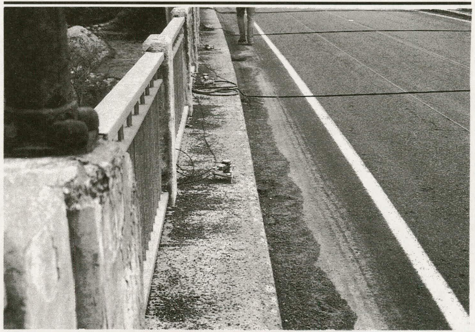
Figure 3 Accéléromètres aimantés installés sur des plaques de mise au niveau.
