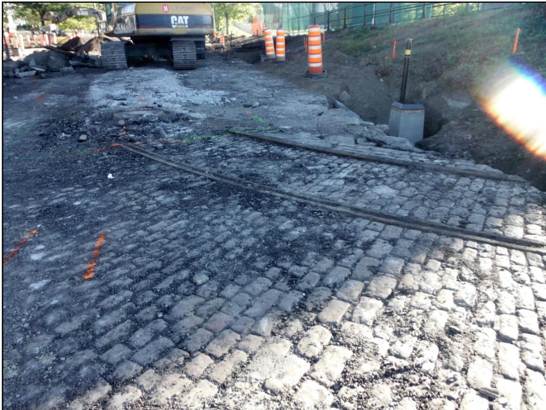
Photo 11 : Vue générale des rails de tramway (6A2) et du pavé de pierres granitiques (6A1) dégagés, direction nord-est (614G-NUM1-1)
