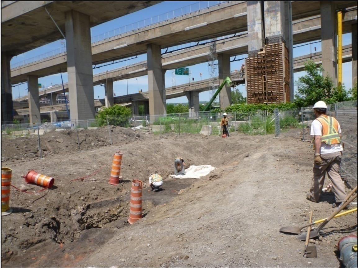
Photo 14 : Implantation des sondages manuels 2A et 2B à l'intérieur de la tranchée mécanique 1F, direction nord (MTL12-23-2-NUM3-10)
