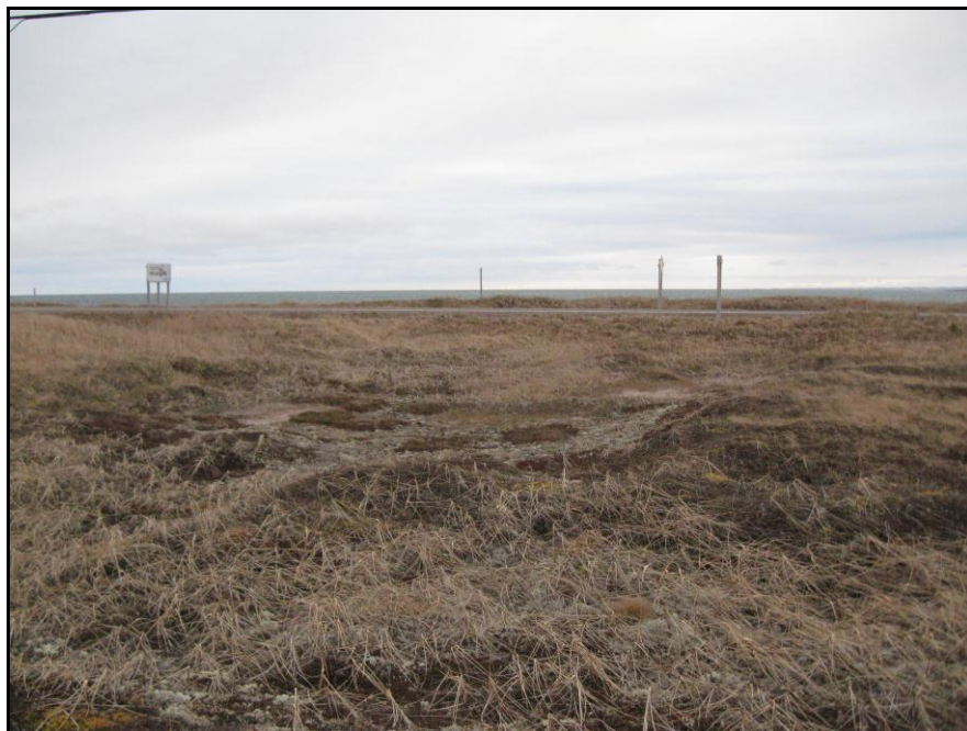
Photo 38 Aire perturbée en association avec les fondations en béton localisées à proximité du chaînage 4+120, vers l'ouest (DUCD-0307-12-264)
