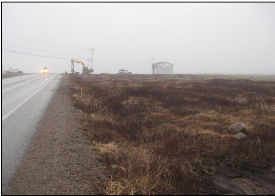
Photo 41 Vue générale du secteur 13, vers le nord (DUCD-0307-12-244)
