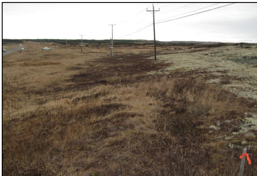
Photo 34 Vue générale du secteur 11, vers le nord (DUCD-0307-12-257)
