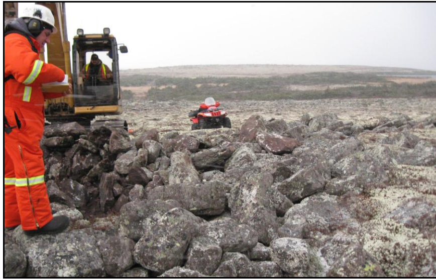
Photo 13 Vue générale du secteur 5, vers le nord (DUCD-0307-12-063)
