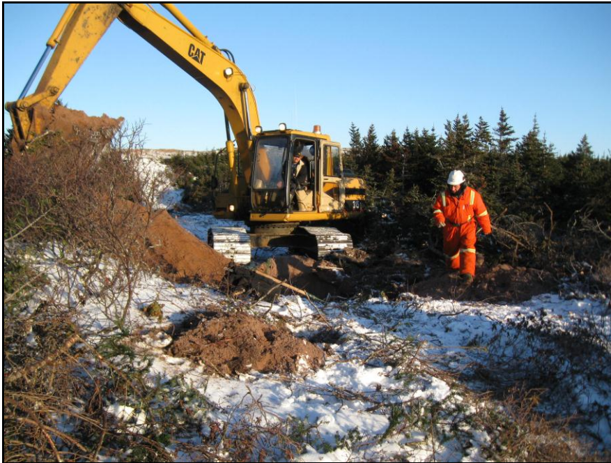
Photo 54 Vue générale du site EiBh-h, vers le nord-est (DUCD-0307-12-318)
