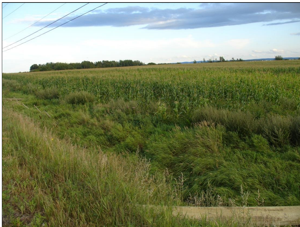
Photo 7: projet 154-08-1147A, municipalité de Saint-Gédéon, route des Quatorze Arpents, aperçu général du secteur d'inventaire. Vue vers le sud-est.
