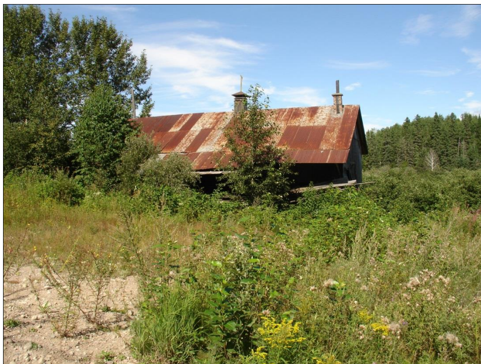
Photo 6 : projet 154-07-1174, municipalité de Normandin, aperçu général du moulin, vue vers l'est
