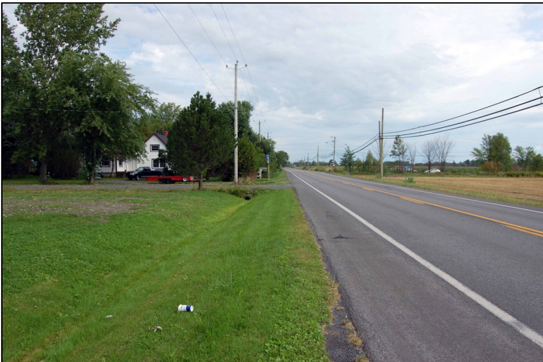
Photo 24 Projet n° 154-06-0423, secteur 1, environnement général du secteur à l'ouest de la route 223, ch 14 + 090, direction nord (PATR11N03-199)
