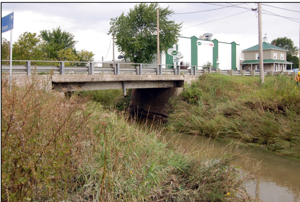
Photo 28 Projet n° 154-90-0629, secteur 2, environnement général, ponceau et rive sud-est du ruisseau, à partir du ch 1 + 140, direction nord-nord-ouest (PATR11N03-208)
