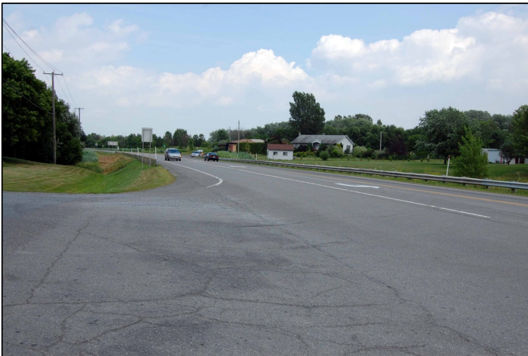
Photo 19 Projet n° 154-07-1250, secteur 1, environnement général du ch 1+015 vers ch 1+108, côté nord de la route, direction est (PATR11N03-104)
