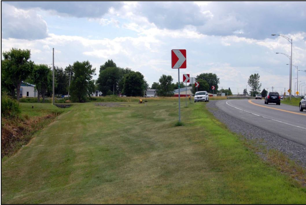
Photo 3 Projet n° 154-99-1092, secteur 1, environnement général du ch 0 + 386 vers ch 0 + 200, direction ouest (PATR11N03-044)
