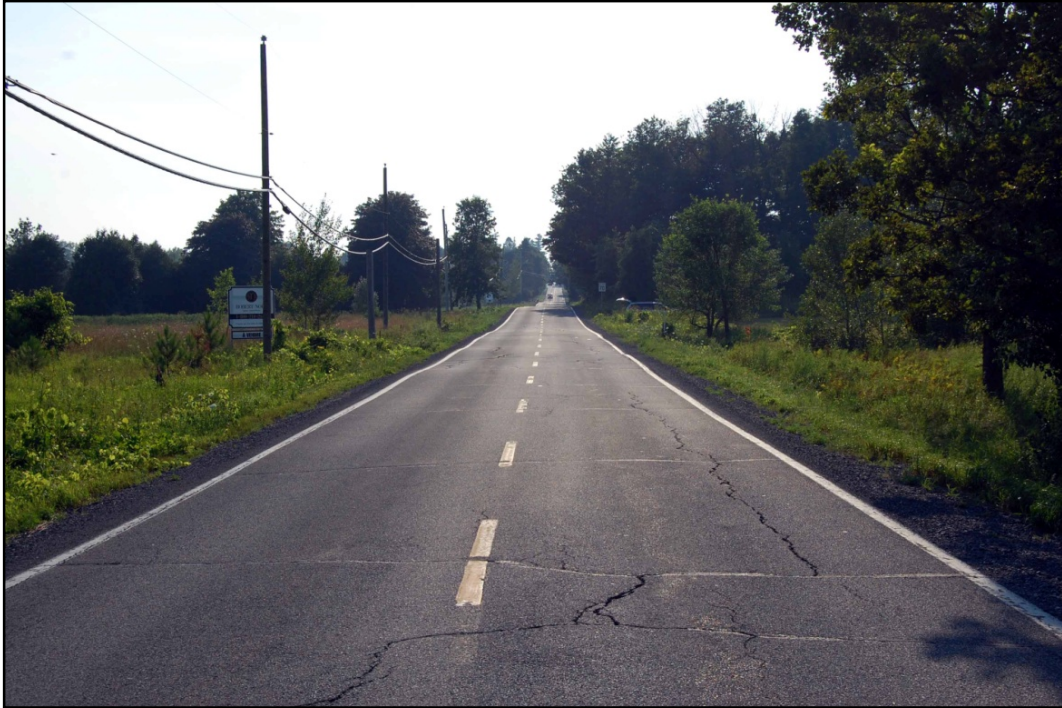
Photo 12 Projet n° 154-08-0892, secteur 1, environnement du ch. 1+245 vers 1+110, direction ouest (PATR11N03-084)
