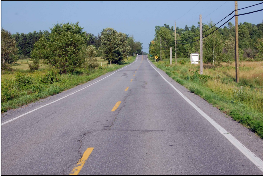
Photo 11 Projet n° 154-08-0892, secteur 1, environnement du ch. 1+110 vers 1+245, direction est (PATR11N03-083)
