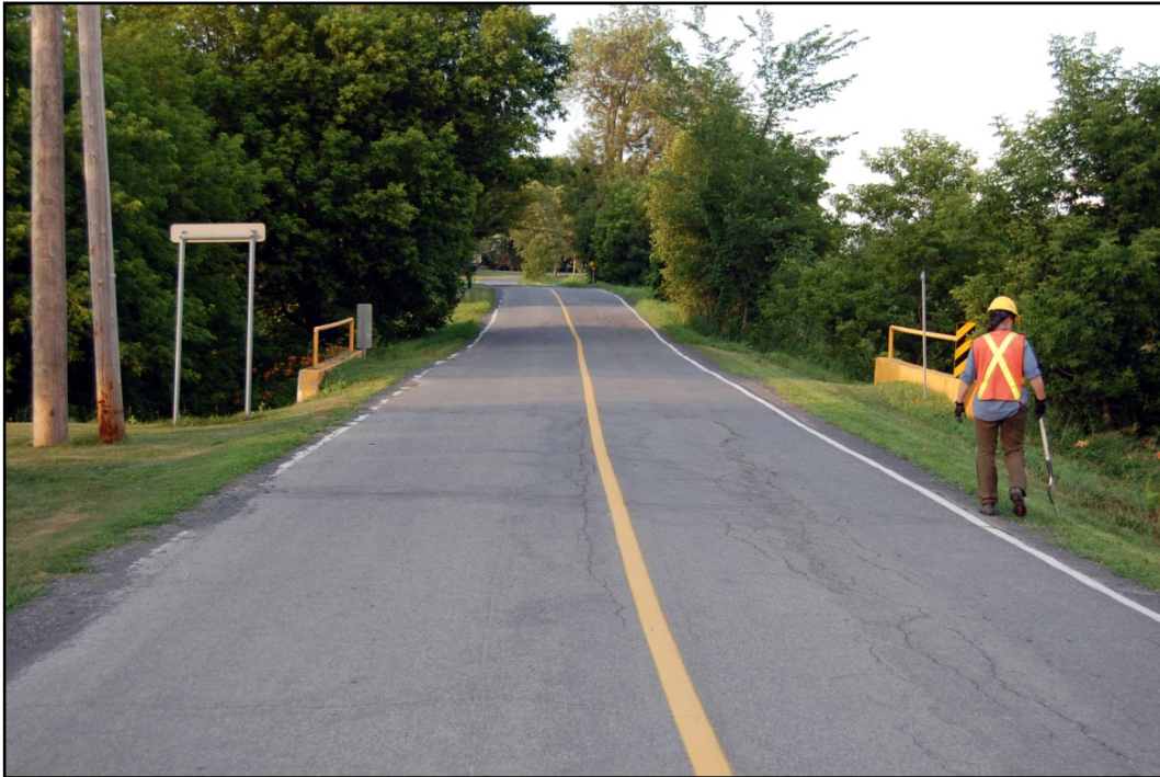
Photo 9 Projet n° 154-99-1081, secteur 1, environnement général, ch 0 + 000 vers ch 0 + 040, direction nord-est (PATR11N03-057)
