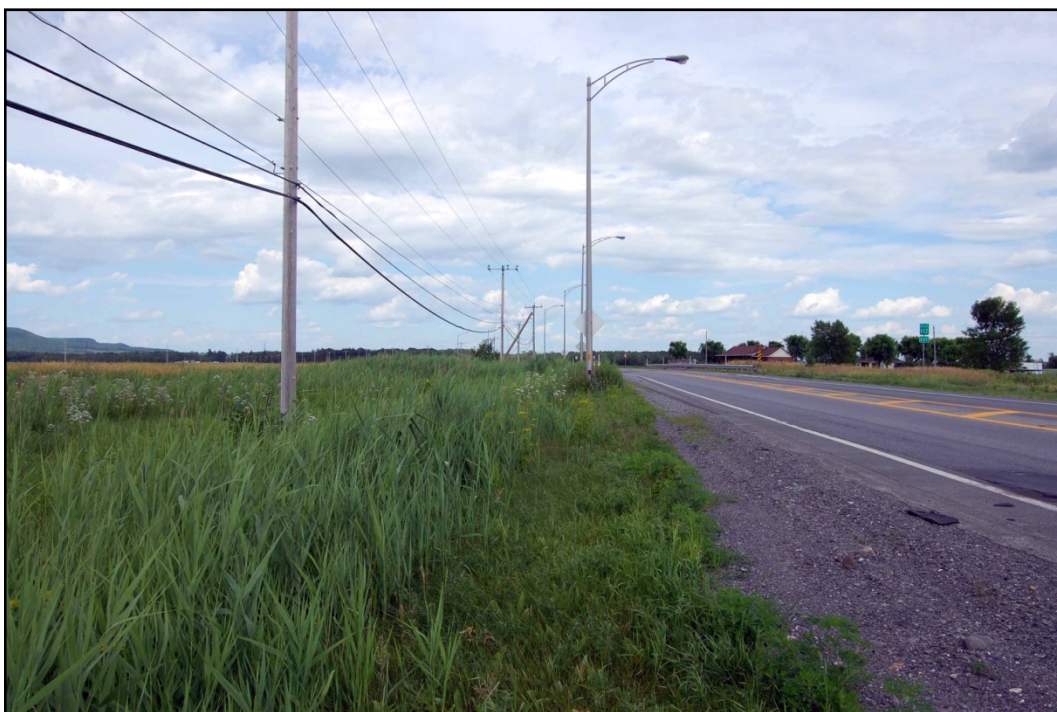
Photo 5 Projet n° 154-99-1092, secteur 3, environnement général du ch 0 + 000 vers ch 0 + 200, direction est (PATR11N03-048)
