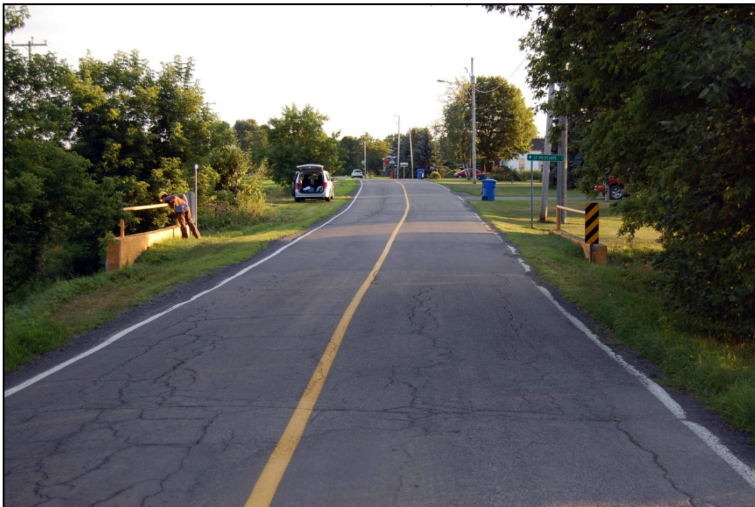
Photo 10 Projet n° 154-99-1081, secteur 1, environnement général, ch 0 + 040 vers ch 0 + 000, direction sud-ouest (PATR11N03-058)
