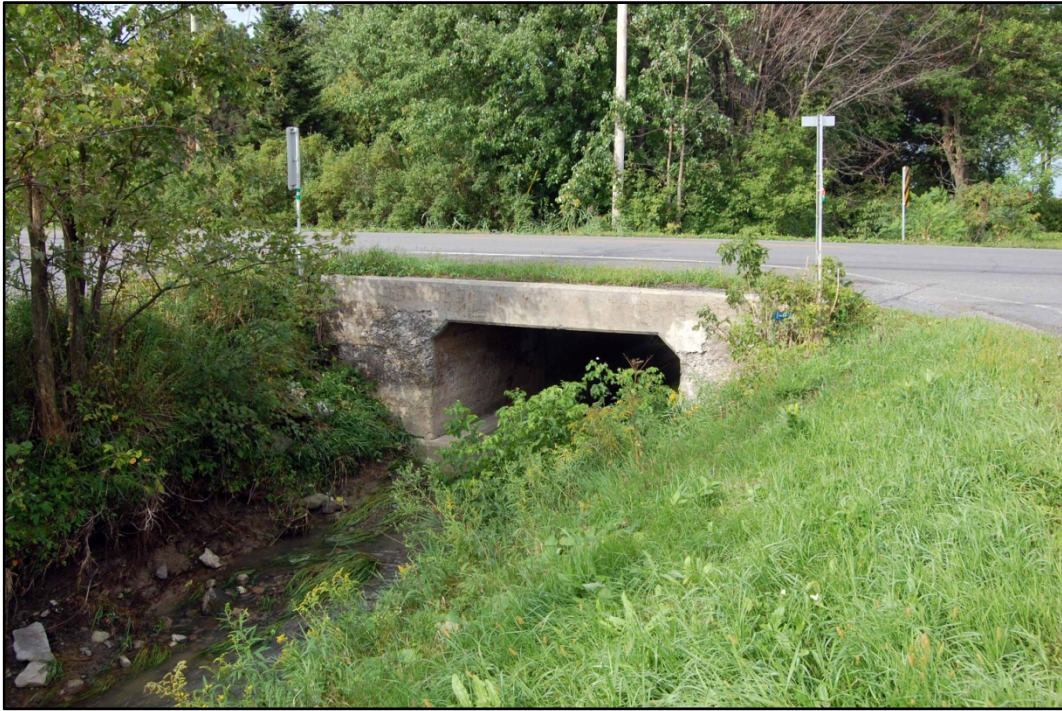
Photo 23 Projet n° 154-06-0423, secteur 1, ponceau du côté est de la route 223, ch 14 + 215, direction sud-ouest (PATR11N03-197)
