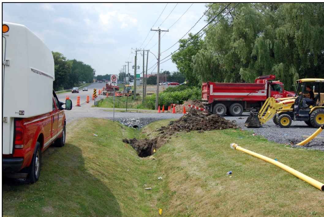
Photo 16 Projet n° 154-05-0777, secteur 1, environnement général, côté nord de la route 112, fossé et travaux en cours (ch 0+430 vers ch 0+200), direction ouest (PATR11N03-099)
