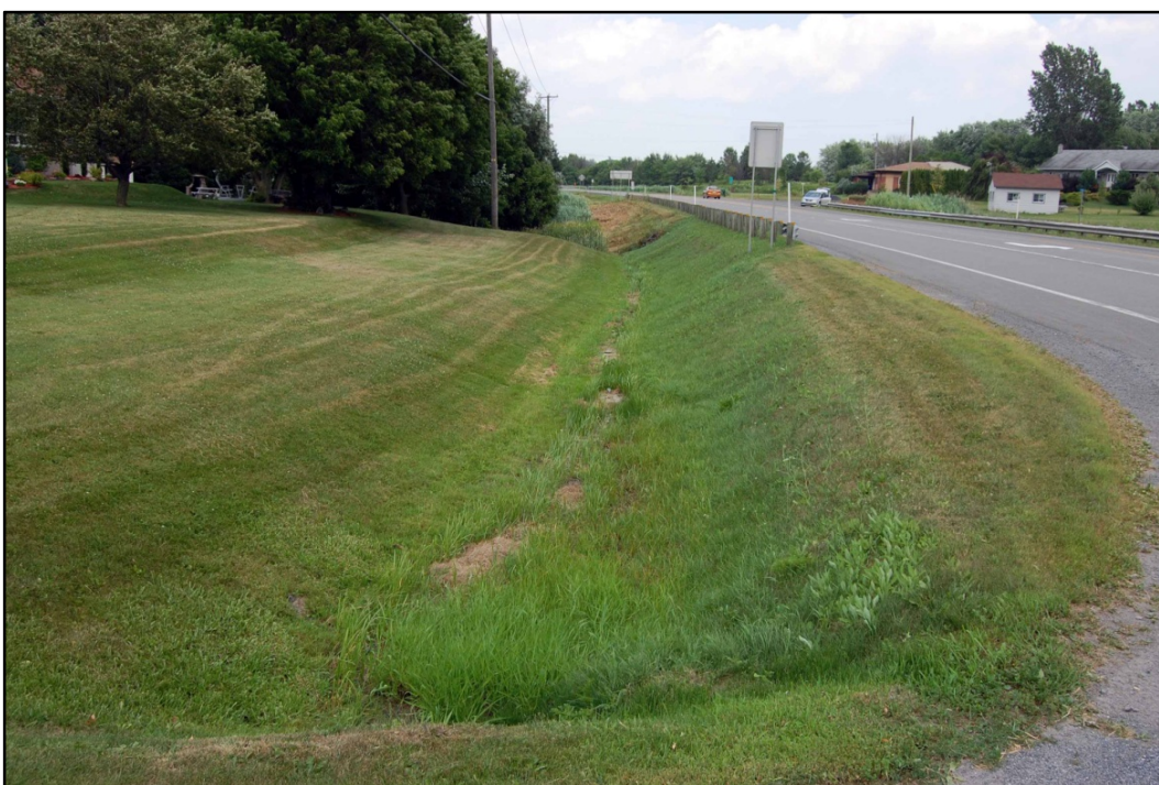
Photo 20 Projet n° 154-07-1250, secteur 1, côté nord de la route 112, fossé asséché avec tuyau en béton armé (TBA), direction est (PATR11N03-105)
