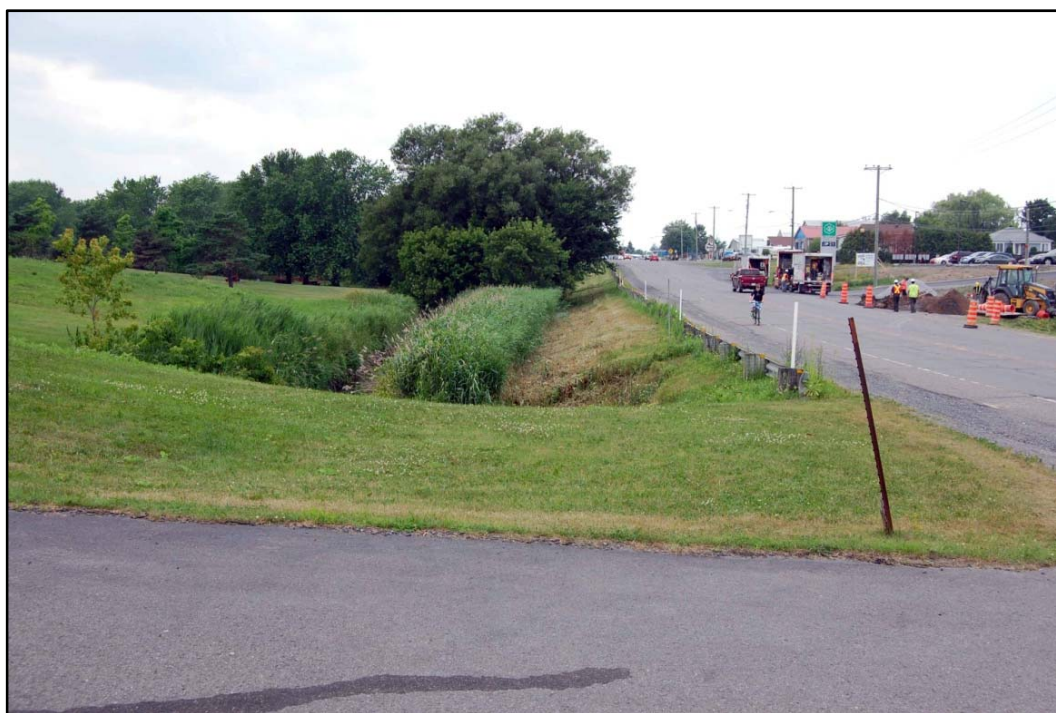
Photo 18 Projet n° 154-05-0777, secteur 2, environnement vis à vis le 2550 route 112, côté sud de la route, direction ouest (PATR11N03-095)
