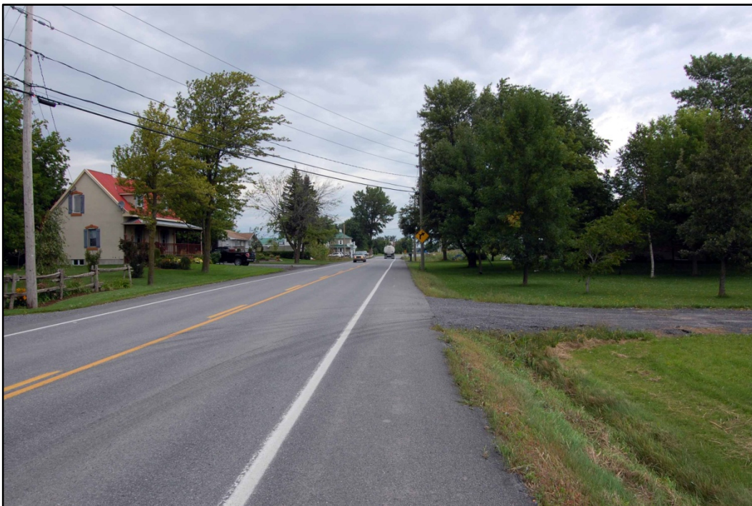
Photo 27 Projet n° 154-90-0629, secteur 1, Environnement général – route 104 à partir du ch 1+ 000, direction nord-est (PATR11N03-204)
