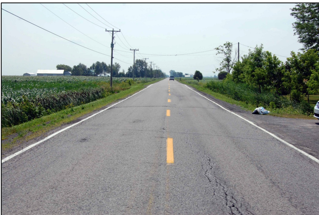
Photo 14 Projet n° 154-08-0898, secteur 1, environnement général du ch. 3+930 vers ch 4+078, direction sud-est (PATR11N03-092)
