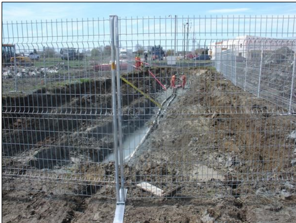
Photo 22 : projet 154-89-0527, municipalité de Saint-Grégoire (Bécancour), travaux en cours.
