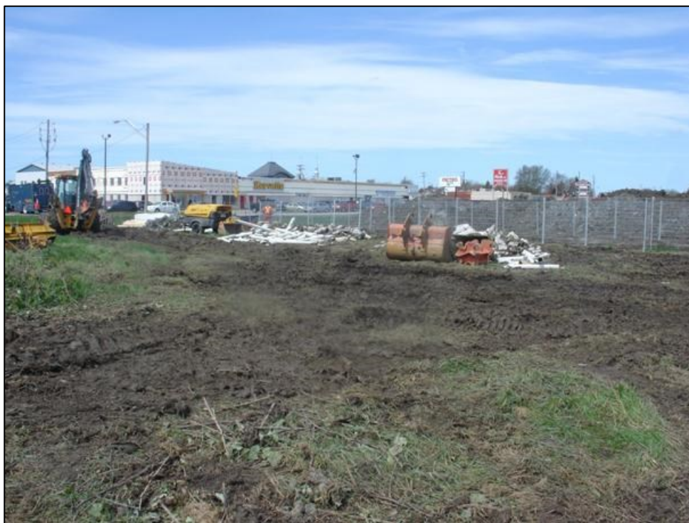
Photo 23 :projet 154-89-0527, municipalité de Saint-Grégoire (Bécancour), travaux en cours.
