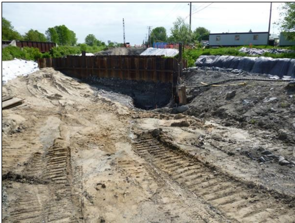
Photo 11 : projet 154-99-0596, municipalité de Yamachiche, route 138, travaux en cours dans la zone d'emprise, vue vers l'est.
