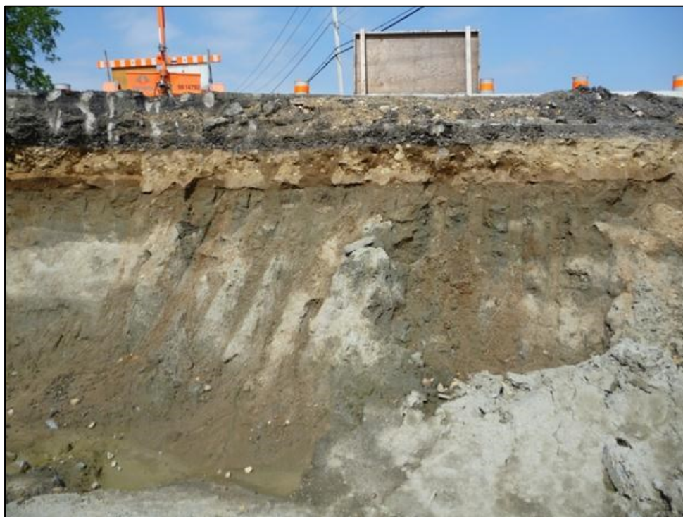
Photo 10 : projet 154-99-0596, municipalité de Yamachiche, route 138, stratigraphie fait de façon mécanique suite aux travaux en cours
