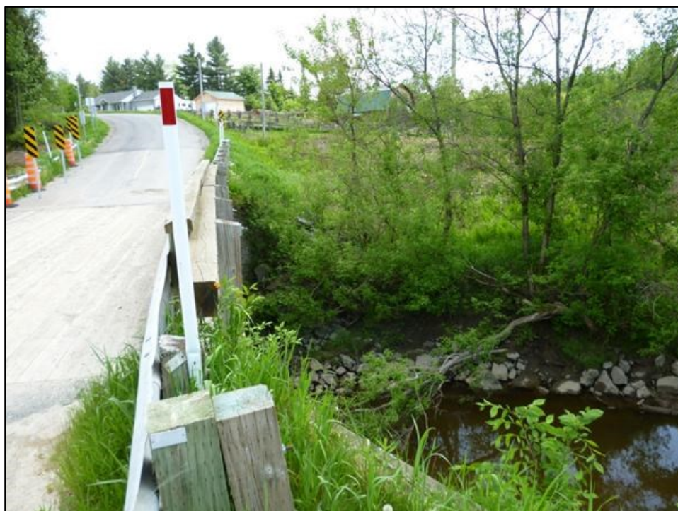
Photo 2 : projet 154-08-0111, municipalité de Kingsey Falls, route Corriveau, aperçu général de l'emprise. Vue vers le sud-est.
