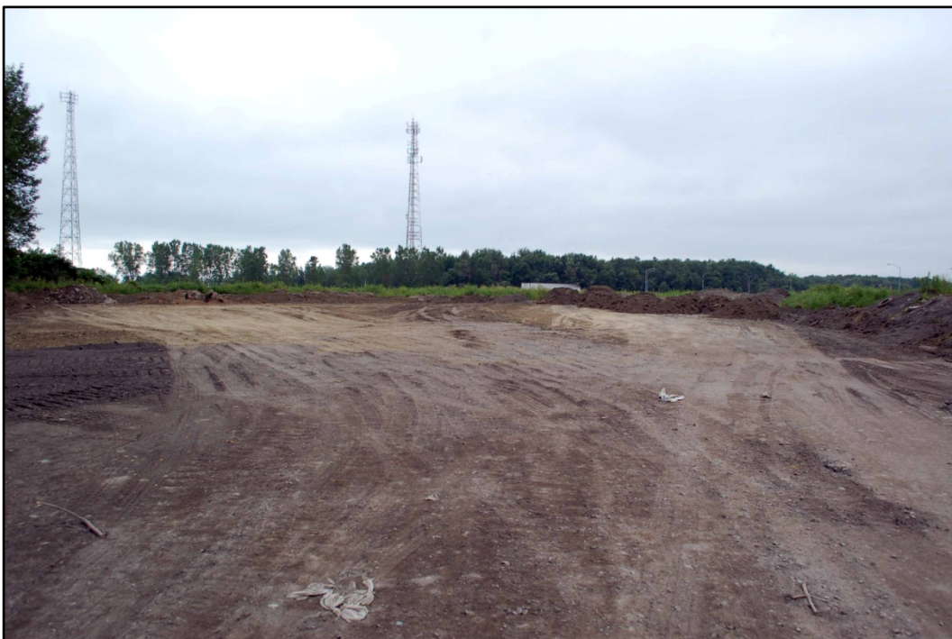
Photo 22 Projet n° 154-08-0209, secteur 1, environnement, secteur décapé, direction sud (PATR11N05-066)
