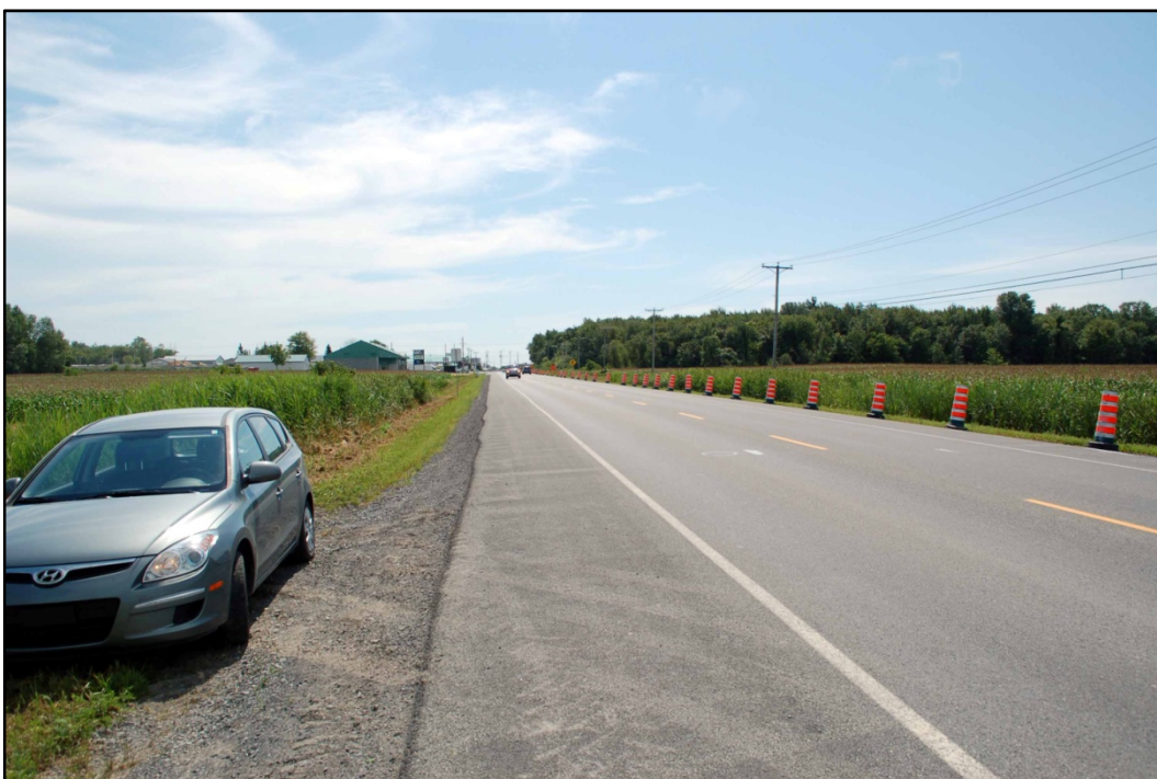
Photo 16 Projet n° 154-07-1503, secteur 2, route 341, environnement au ch. 12 + 870, direction sud-est (PATR11N05-050)
