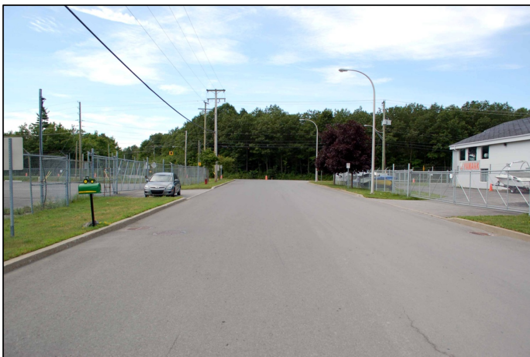
Photo 18 Projet n° 154-07-1503, secteur 3, environnement chemin de l'Industrie, du ch. 10 + 060 vers 10 + 020, direction ouest (PATR11N05-055)
