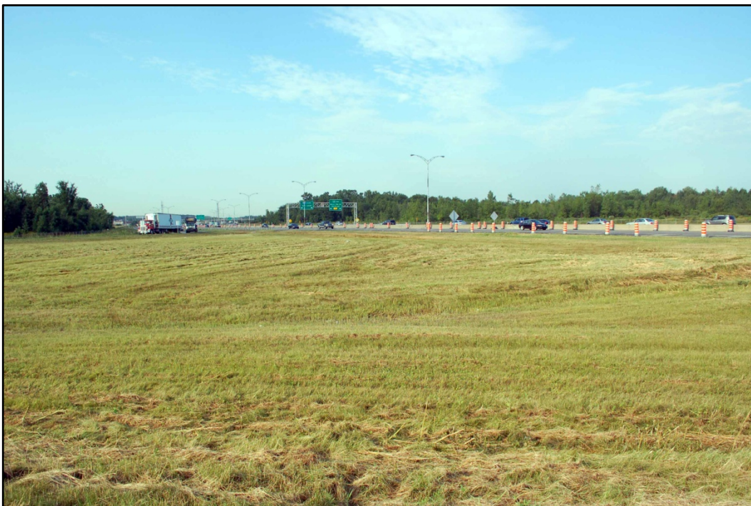
Photo 44 Projet n° 154-10-0825, secteur 2, environnement de la zone sud-est, direction nord (PATR11N05-118)
