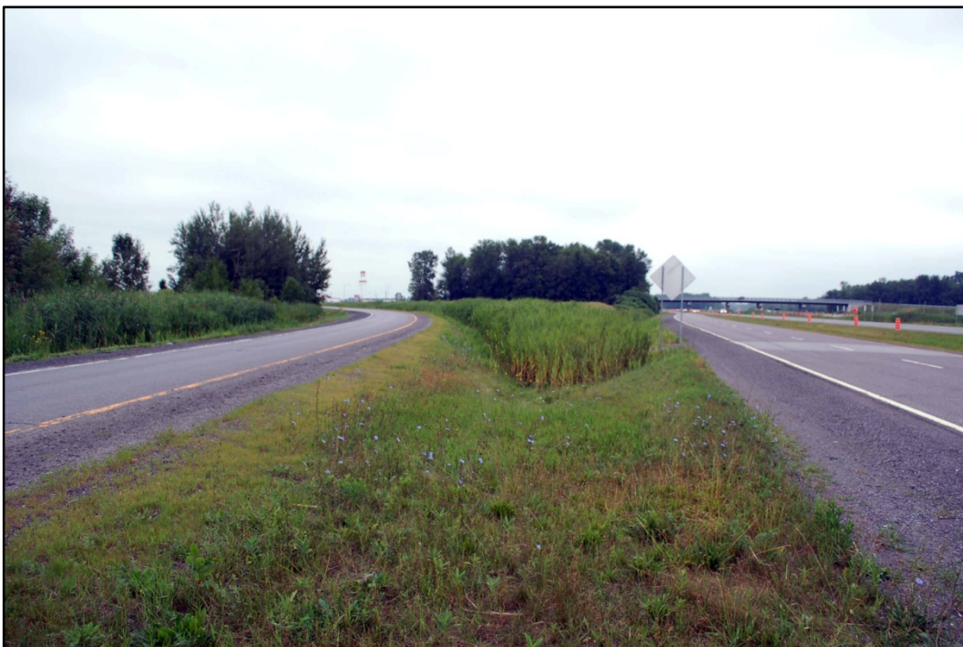
Photo 20 Projet n° 154-08-0209, secteur 1, environnement, bretelle J du ch. 15 + 200 vers 15 + 000, direction nord-est (PATR11N05-060)
