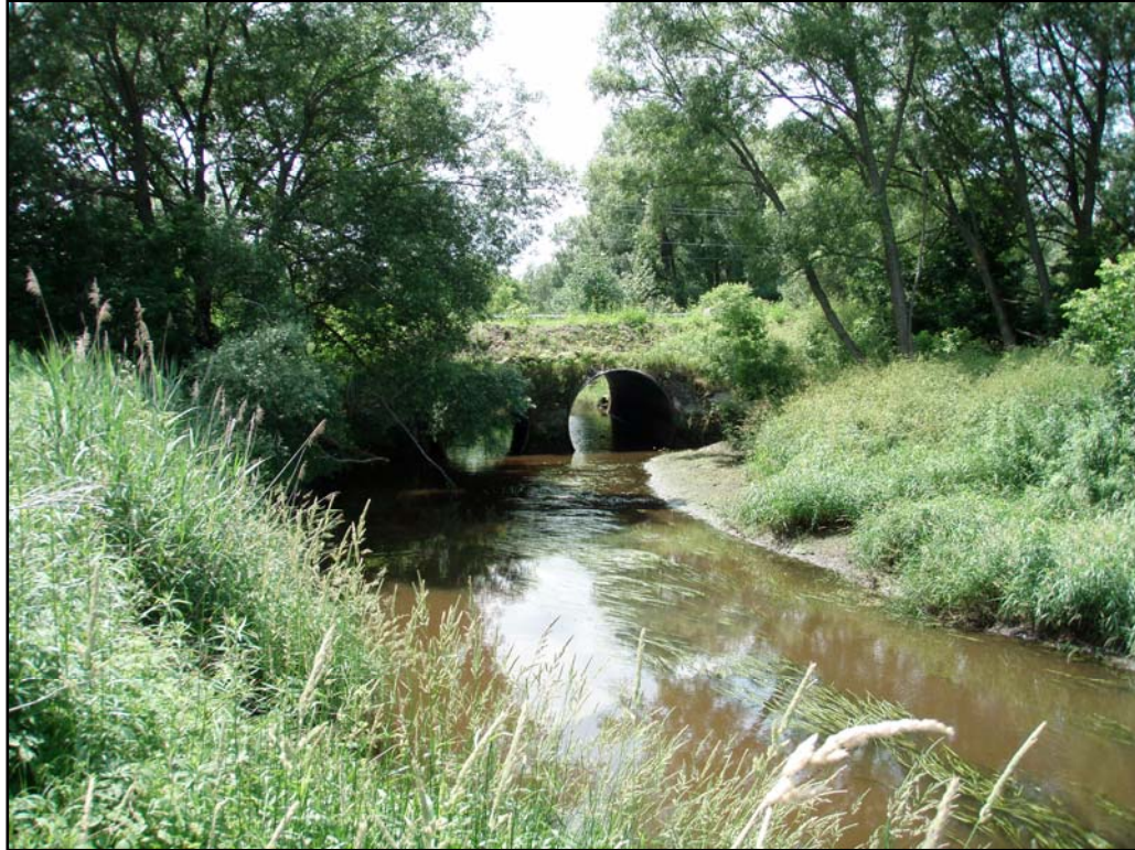
Photo 10 : Ponceau P-14163, secteurs 2 et 3, direction ouest (154-08-0630-10-NUM1-2)
