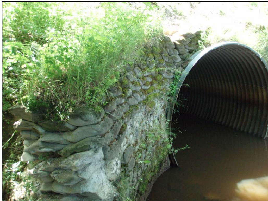
Photo 11 : Mur de soutènement, secteur 3, direction nord-ouest (154-08-0630-10-NUM1-8)
