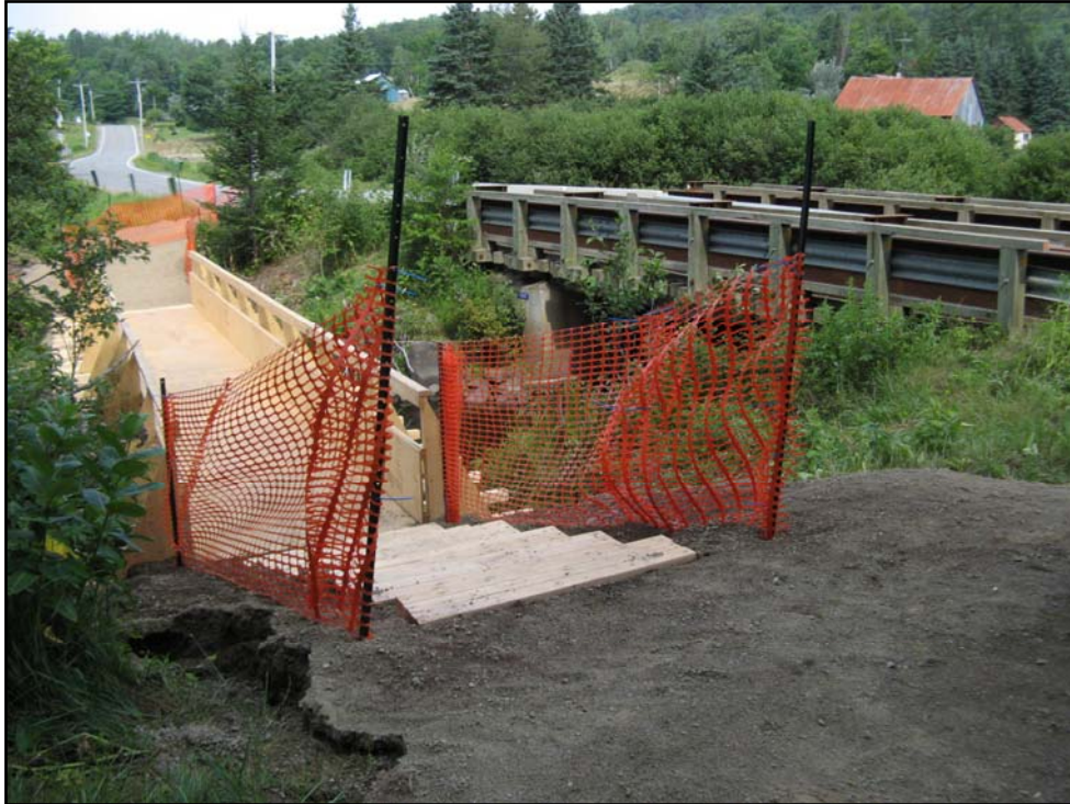
Photo 21 : Vue générale du pont P-00457, secteurs 1 et 2, direction nord-ouest (154-08-1419-10-NUM1-2)
