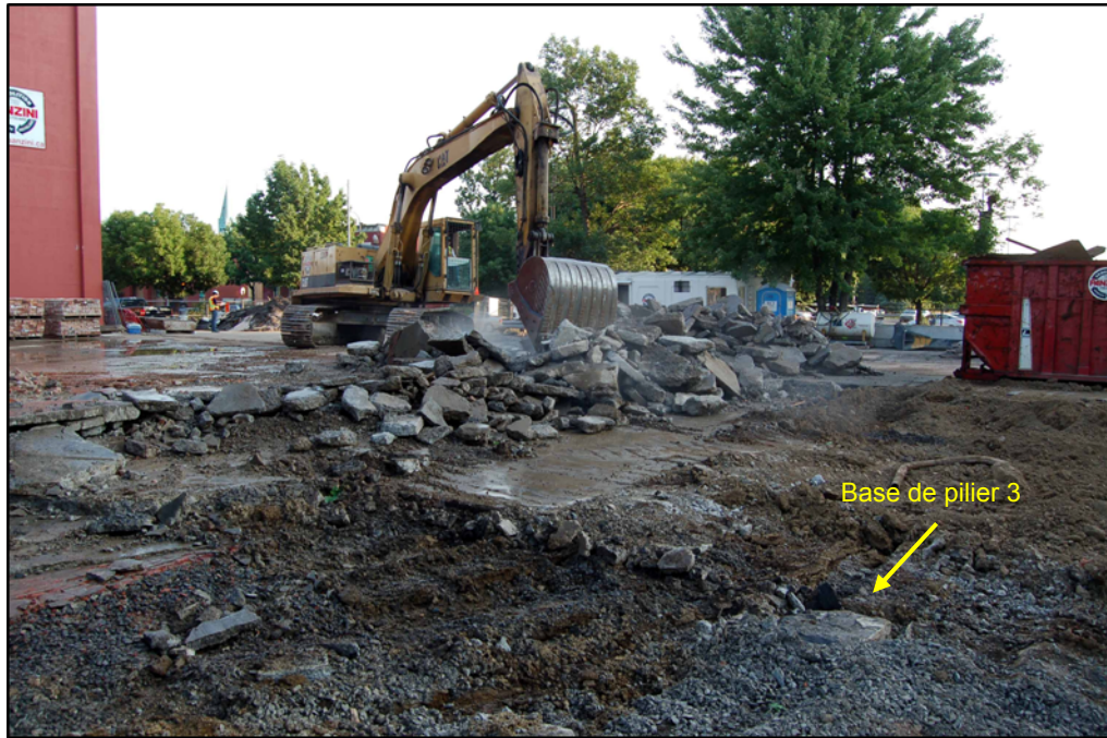
Photo 16 Position de la base de pilier 3, direction nord (PATR12N06-115)
