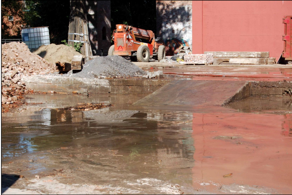
Photo 1 Plan incliné. Circulation entre les 2 paliers, direction nord-ouest (PATR12N06-021)
