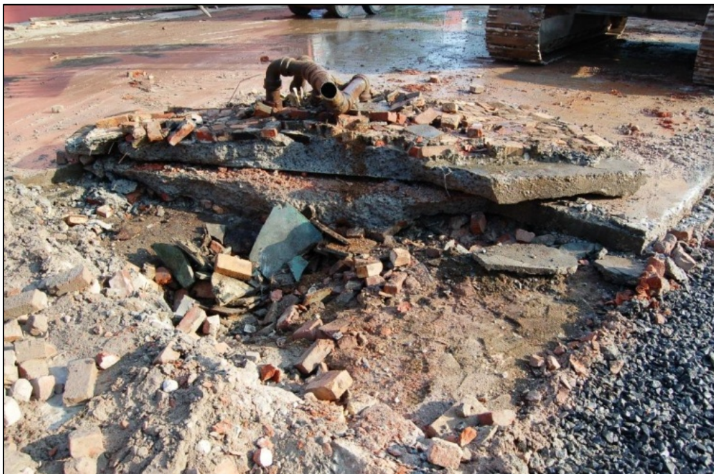
Photo 4 Les niveaux de béton, tuyaux, secteur ouest de la dalle nord, direction nord (PATR12N06-118).
