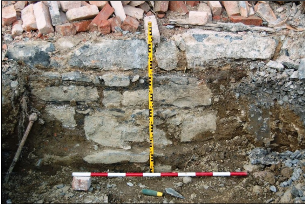
Photo 7 Mur de fondation ouest. Vue vers l'ouest à 8 mètres du coin sud-ouest, direction ouest (PATR12N06-060).
