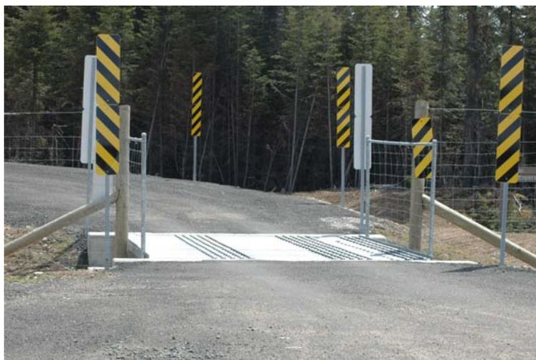
Figure 6 – Passage routier anti-cervidés utilisé à l'entrée des routes secondaires pour réduire le risque qu'un cervidé accède à la route (Photographie : Marius Poulin).
