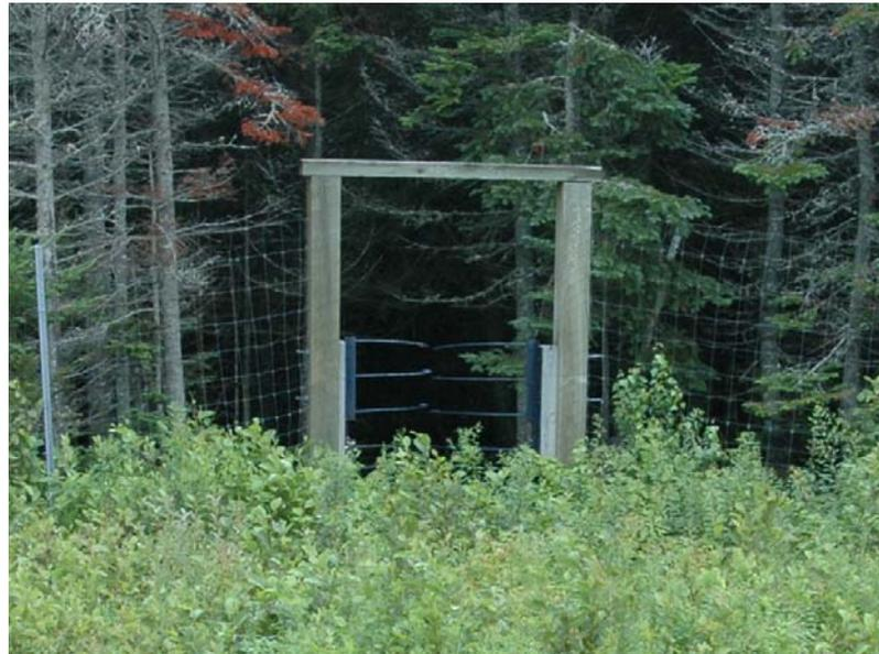
Figure 7 – Barrière à sens unique intégrée à une clôture d'exclusion pour permettre aux cervidés de réintégrer l'habitat adjacent à la route (Photographie : Marius Poulin).
