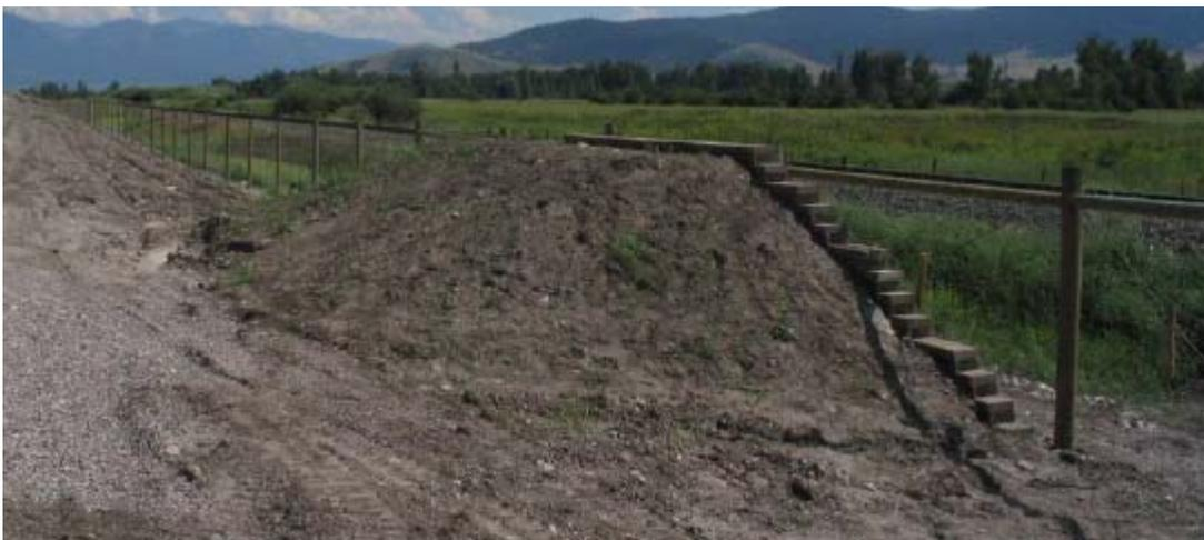
Figure 8 – Rampe d'échappement utilisée pour permettre aux cervidés de réintégrer l'habitat adjacent à la route (source : Huijser et Paul 2008).
