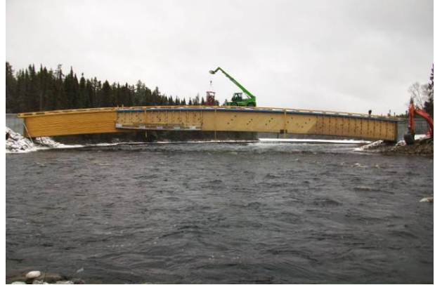
Figure 6 - Vue d'ensemble du pont
