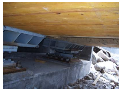
Figure 22 - Appareil d'appui et poutre
