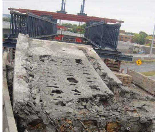
Ces deux poutres se déplaçaient sur un système de rails et de treuils placé au-dessus des poutrelles de support jusqu'à la travée à démolir. Deux vérins étaient installés sur chacune des poutres mobiles et circulaient perpendiculairement à l'axe de à l'aide d'un système de rails et de treuils placé au-dessus des poutres mobiles. La structure à démolir pouvait donc être attachée aux vérins, sciée par le dessus et déplacée jusqu'à l'approche pour y être démolie en sécurité.
