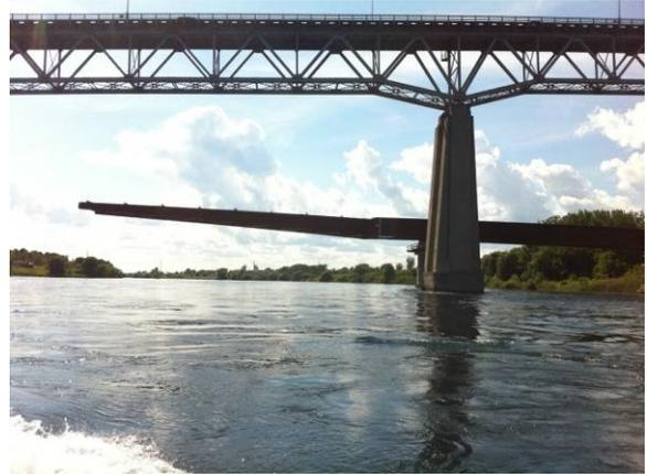
D'autre part, nous devons également dû modifier les plaques d'épaisseurs des semelles inférieures, puisqu'elles ne permettent pas le passage adéquat des rouleaux. Nous suggérons d'abord d'élargir simplement la semelle et de la raidir adéquatement de manière à ce que les rouleaux n'interfèrent pas avec les plaques d'épaisseurs.
