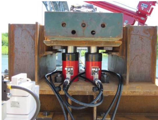
Puisque nous utilisons des appuis à rouleaux qui reposent sur des vérins, ceux-ci sont en mesure de fournir la flexibilité nécessaire lors de la rotation.
