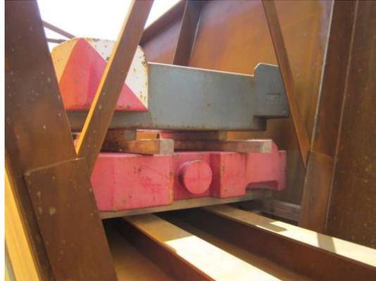
Bien qu'il soit simple d'ajouter des contrepoids, il en est autrement sur la manipulation de ceux-ci lorsque vient le temps de faire basculer la structure vers l'avant de manière à ce que le nez s'appuie sur le support en dessous.
