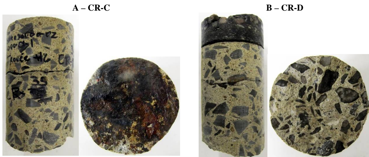
Figure 10 : Carottes de béton prélevées dans une zone où l'activité de corrosion est élevée
