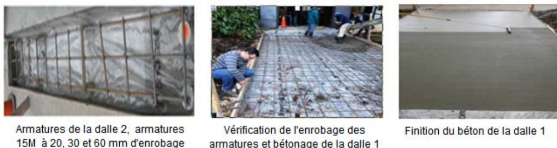
Figure 2 : Préparation des dalles extérieures
