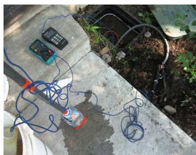
Mesure du potentiel de corrosion sur la dalle extérieure 1.
