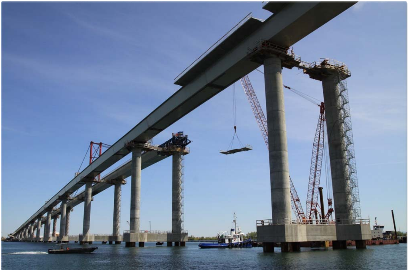
Travaux d'installation de dalles et poussage 2 ème tablier
