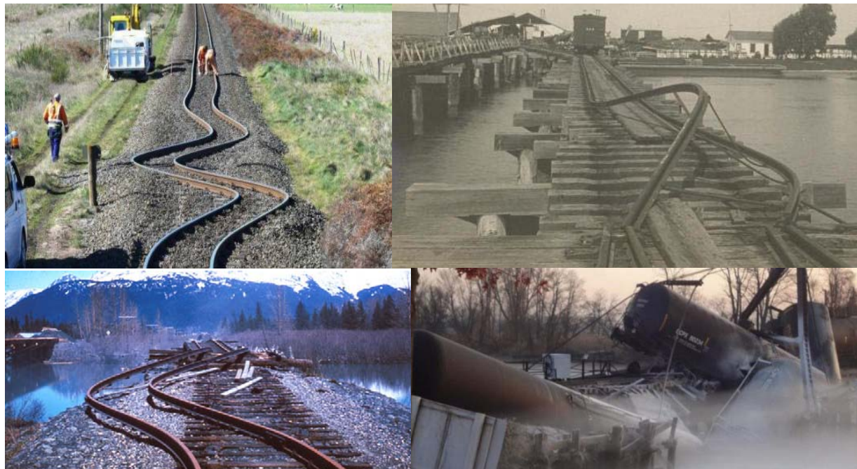
FIGURE 6 DIVERSES CONSÉQUENCES DU FLAMBEMENT DES RAILS
