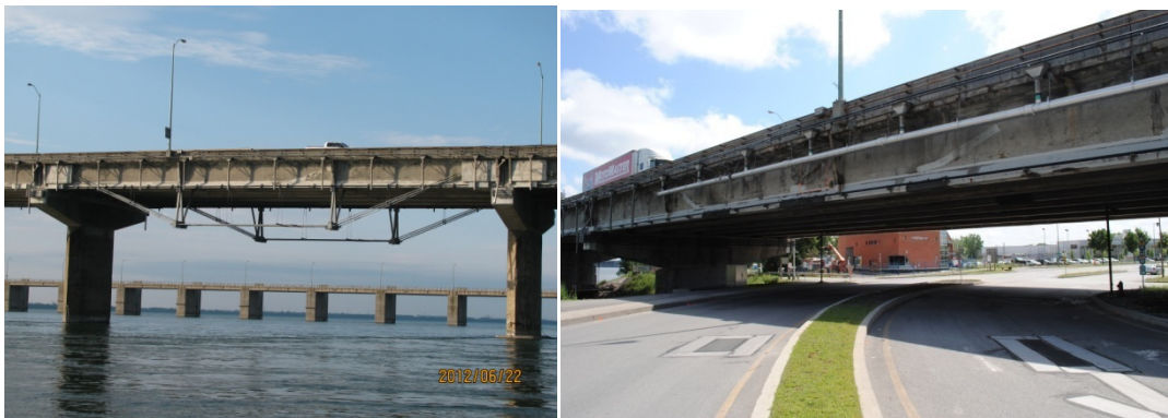
Photo 1 – Renforcement du type arbalète ou Queen Post
