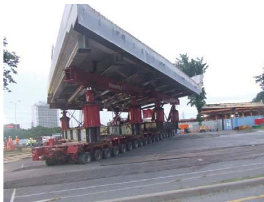
Figure 2 : Remplacement de pont à l'aide de la méthode rapide
