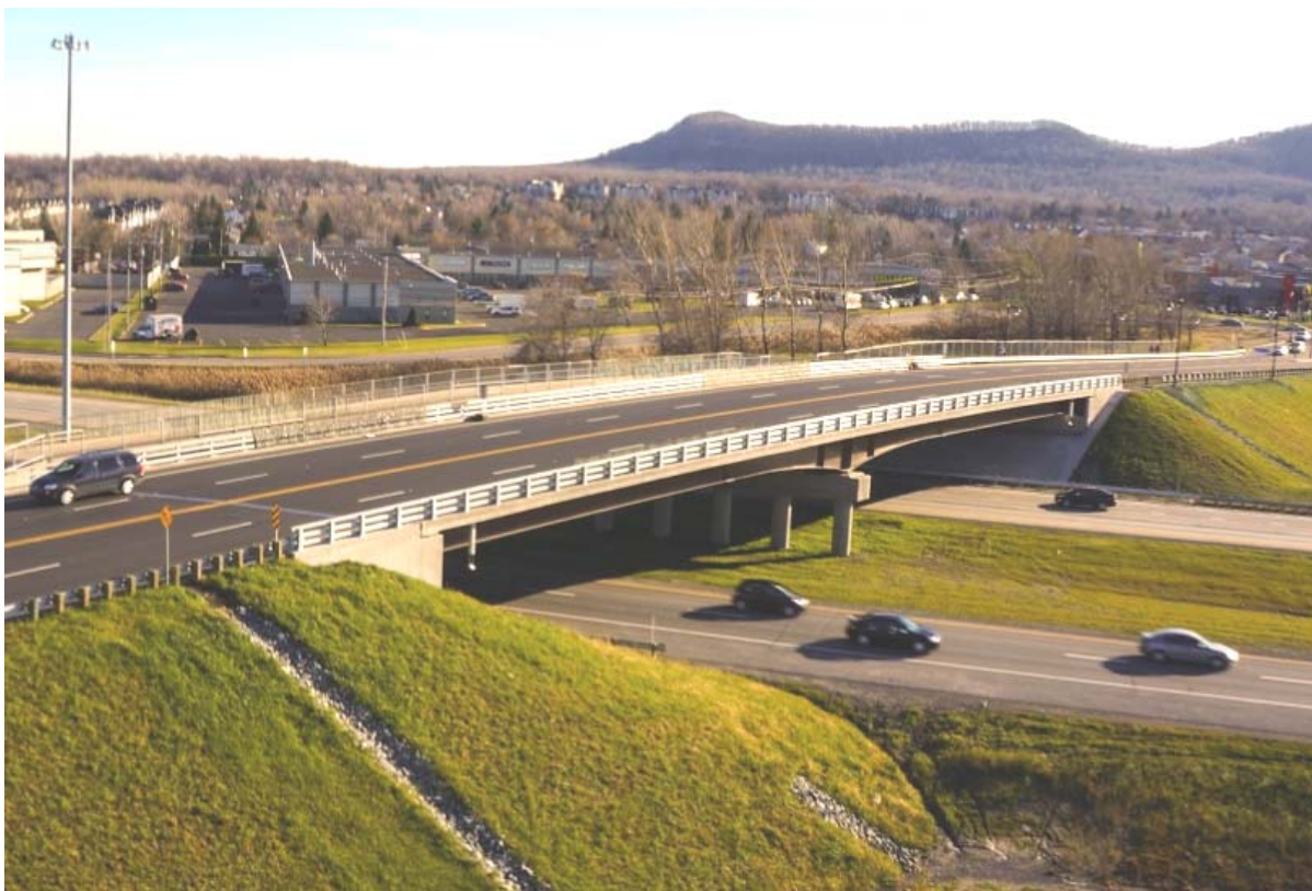
Figure 7 : Vue d'ensemble du nouveau pont
