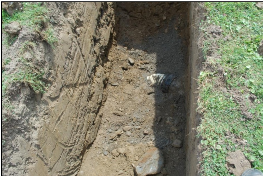
Photo 25 Tuyau de PVC au fond de la tranchée H. (PATR11N03-184)
