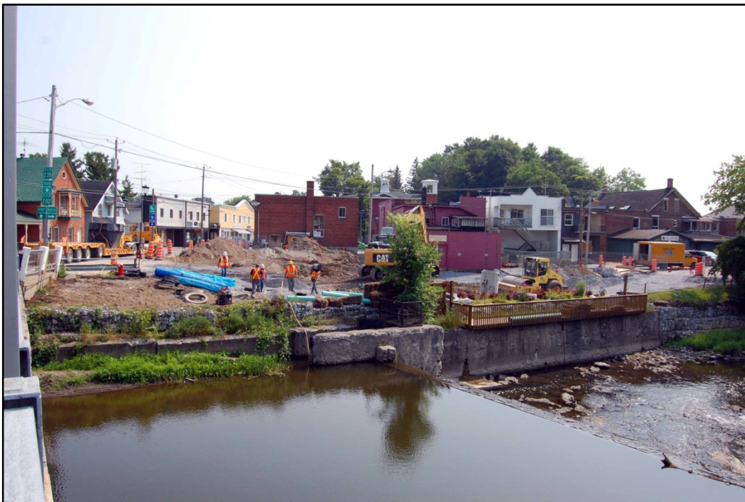
Photo 15 Projet n° 154-98-0818, secteur 2, détail côté ouest du pont, rive sud de la rivière, travaux en cours, direction sud-est (PATR11N03-078)
