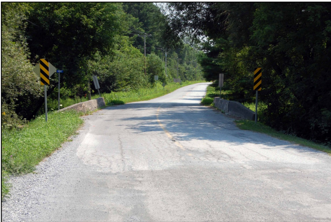
Photo 9 Projet n° 154-98-0781, secteur 1, environnement général, direction sud-ouest (PATR11N03-064)
