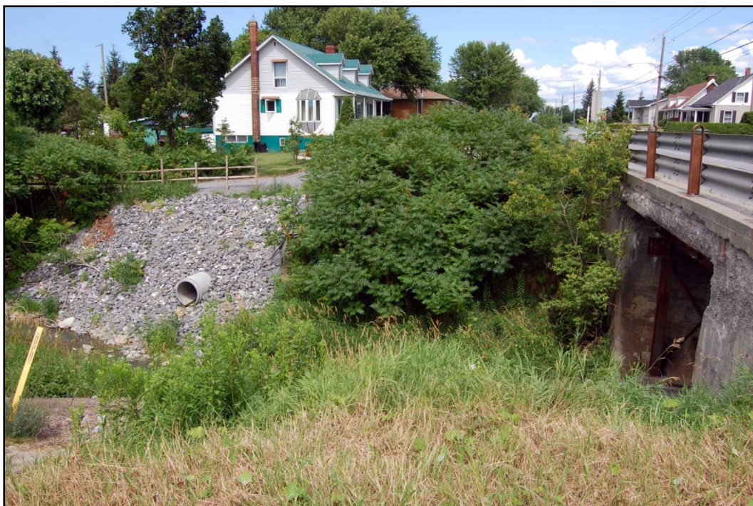
Photo 8 Projet n° 154-99-0953, secteur 1, détail, environnement général, installation de gaz et de tuyau d'évacuation des eaux de pluie, côté nord-ouest, ch. 0 + 620 direction nord-est (PATR11N03-033)
