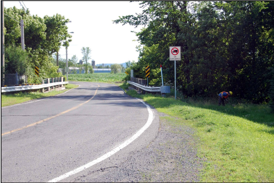
Photo 5 Projet n°154-90-0484, secteur 1, environnement général, direction sud-ouest (PATR11N03-040)
