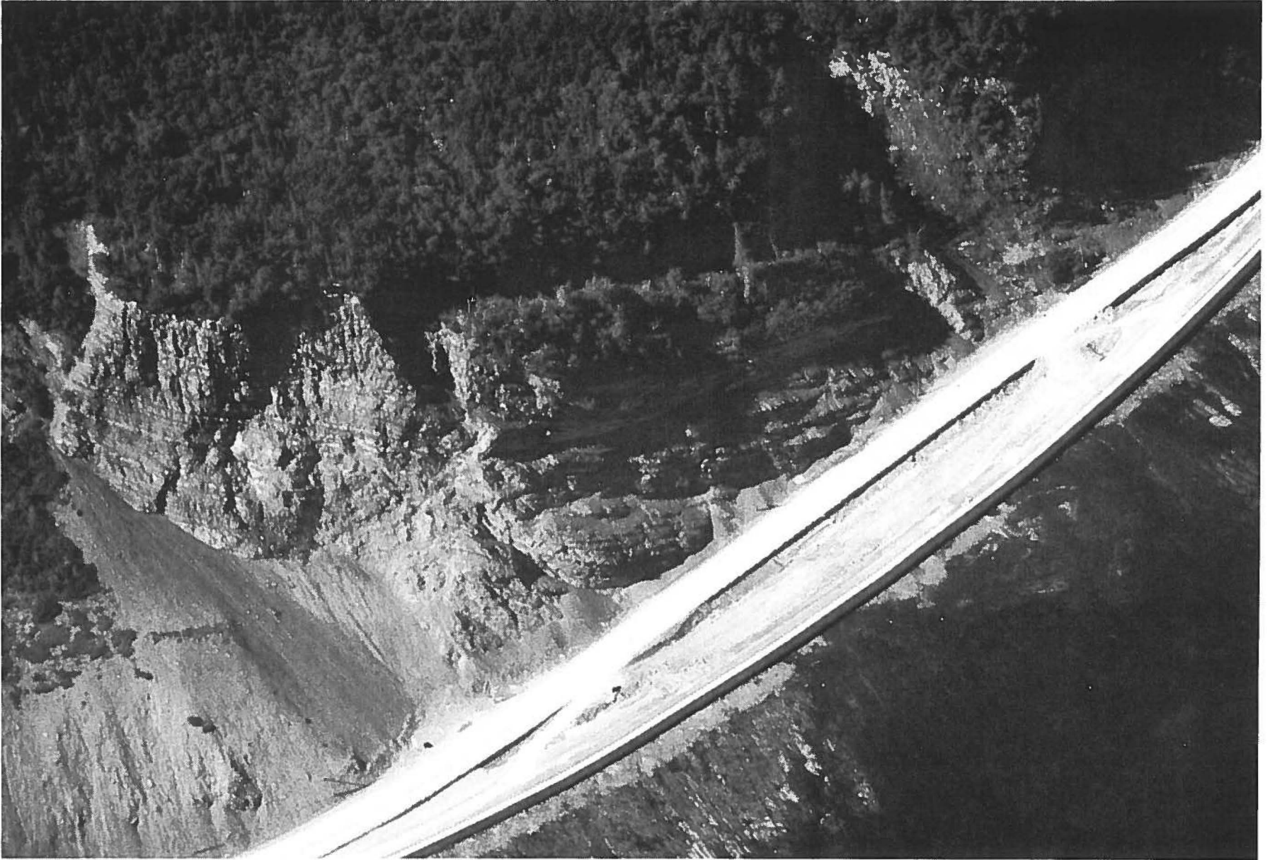
PHOTO 1: Vue aérienne du site
