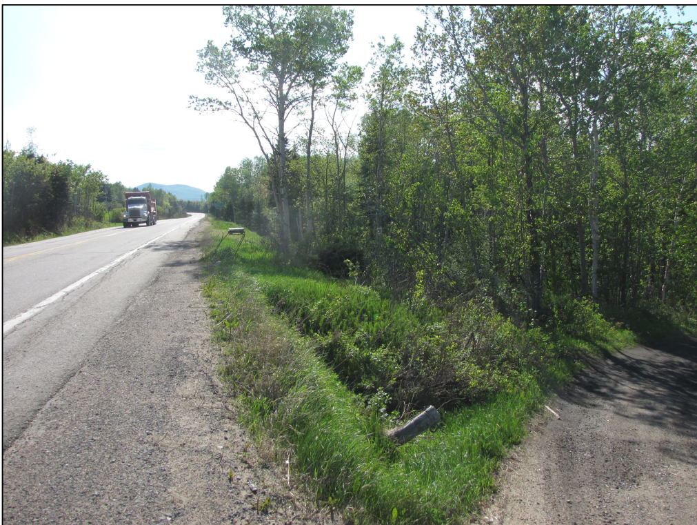
Photo 35 : Projet n° 154-91-1317, vue générale de l'emprise, chaînage 10+410, côté nord de la route 138, municipalité de Saint-Aimé-des-Lacs, direction ouest (photo n° 154-91-1317-27)
