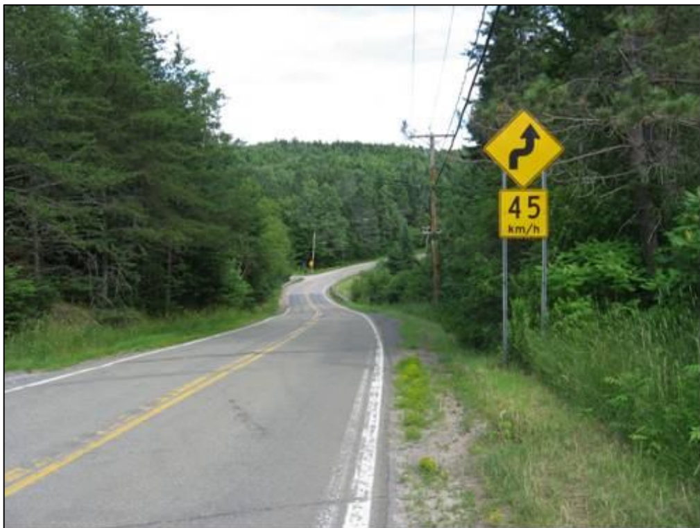
Photo 6 : Projet n° 154-07-1457, vue générale de l'emprise depuis le haut du plateau au nord du ruisseau, chaînage 5+520, route 371, municipalité de Saint-Gabriel-de-Valcartier, direction est (photo n° 154-07-1457-13)
