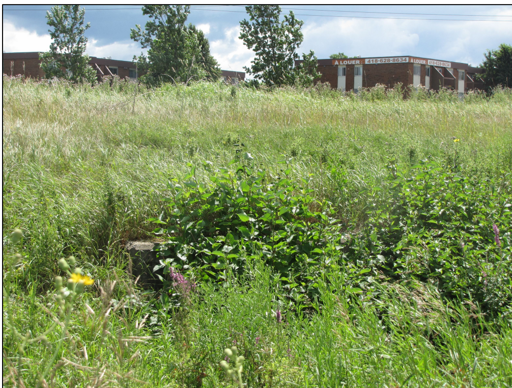
Photo 25 : Projet n° 154-09-0958, vue d'un caniveau en béton, secteur 2, dans la portion sud de la bande de terre du côté sud de la bretelle d'accès de l'autoroute Laurentienne Nord vers l'autoroute Félix-Leclerc Est, ville de Québec, direction sud-est (photo n° 154-09-0958-043)
