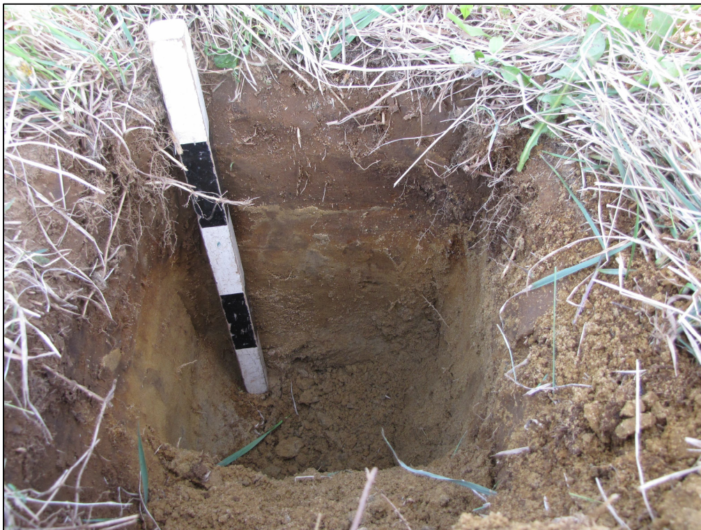
Photo 34 : Projet n° 154-91-1317, paroi d'un sondage réalisé au chaînage 10+430, côté sud de la route 138, municipalité de Saint-Aimé-des-Lacs, direction est (photo n° 154-91-1317-17)
