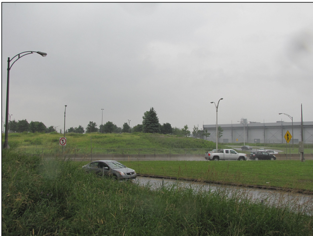
Photo 19 : Projet n° 154-08-1162, vue générale de l'emprise, buton surélevé (remblai) dans la boucle de l'accès Soumande/Laurentienne Nord, direction est (photo n° 154-08-1162-13)
