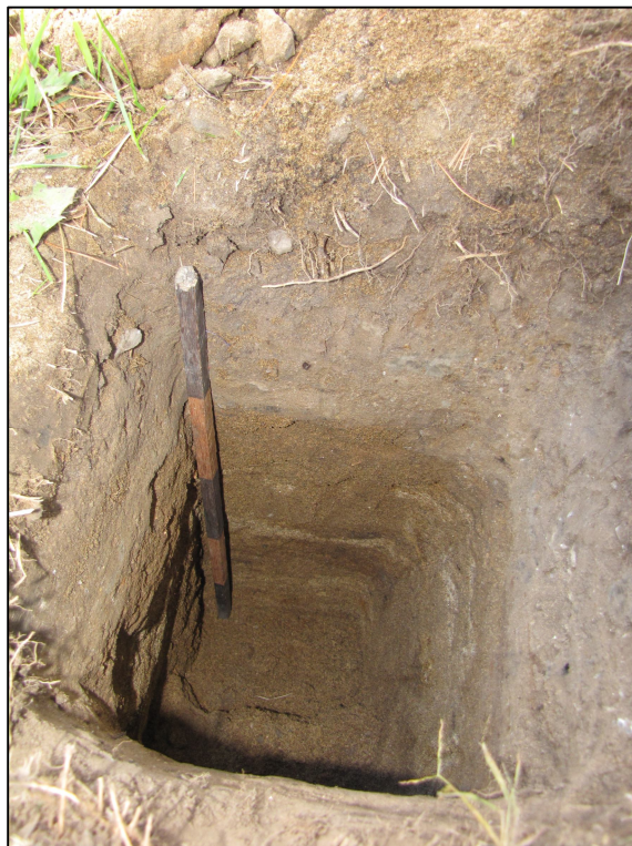
Photo 10 : Projet n° 154-07-2124, paroi d'un sondage, chaînage 1+200, route 365, municipalité de Pont-Rouge, direction nord (photo n° 154-07-2124-20)
