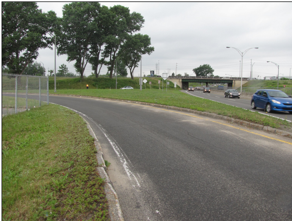
Photo 18 : Projet n° 154-08-1162, vue générale de l'emprise, côté ouest de l'autoroute Laurentienne, direction nord (photo n° 154-08-1162-3)
