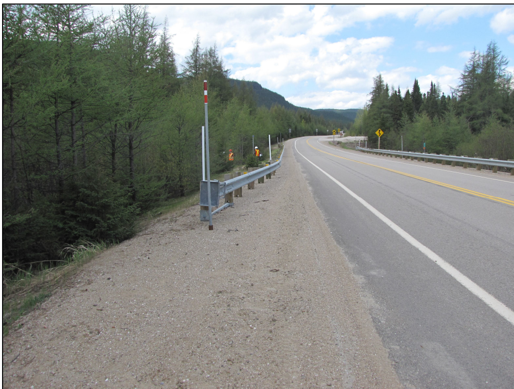
Photo 30 : Projet n° 154-11-0817, vue générale de l'emprise, chaînage 0+950, côté ouest de la route 381, direction nord (photo n° 154-11-0817-01)
