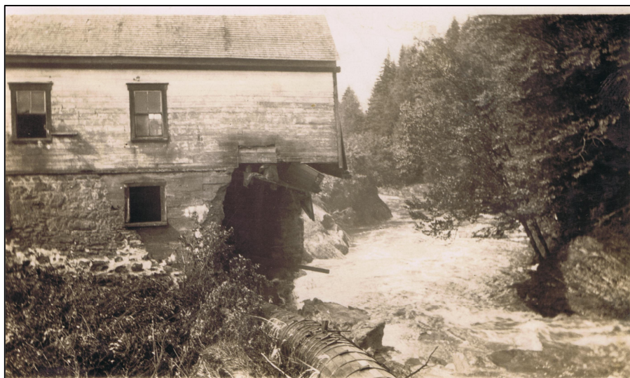
Photo 37 : Projet n° 154-09-0389, site CcEs-d, coin nord-est du moulin après sa destruction par la crue des eaux de la rivière Chassé, en 1935 (source : Claude Chassé, collection privée « Arthur Chassé/Adélia Roy »)
