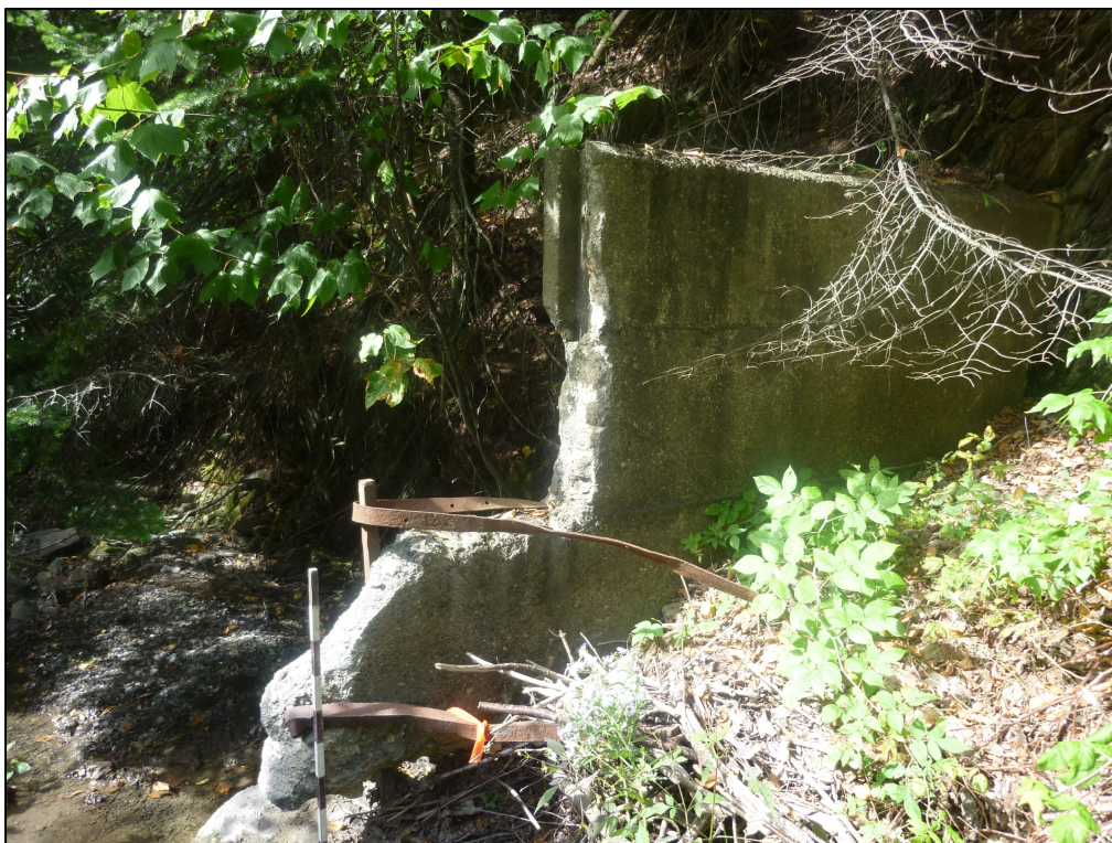
Photo 54 : Projet n° 154-09-0389, site CcEs-d, opération 3, aménagement de béton 3A300, direction nord-est (photo n° 154-09-0389-238)
