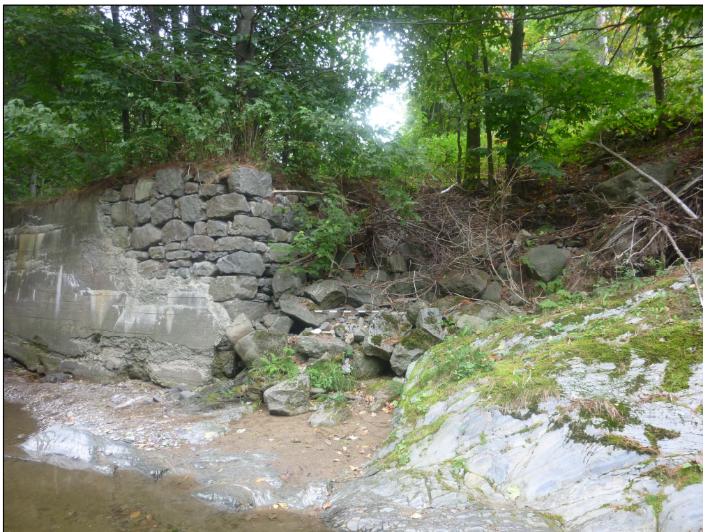
Photo 45 : Projet n° 154-09-0389, site CcEs-d, sous-opération 1A, mur de fondation ouest du moulin (1A300), direction sud-est (photo n° 154-09-0389-122)
