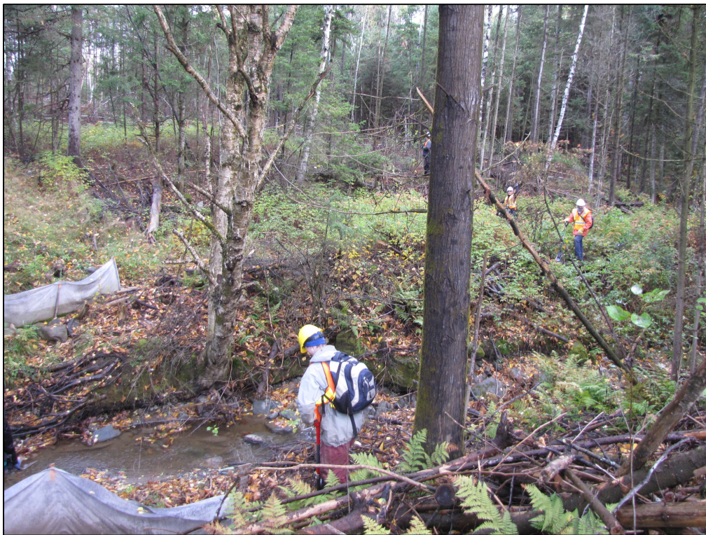
Photo 28 : Projet n° 154-09-0389, vue générale de l'emprise, secteur 2, chaînage 6+800, côté est de l'autoroute 73, municipalité de Sainte-Marie, direction ouest (photo n° 154-09-0389-35)
