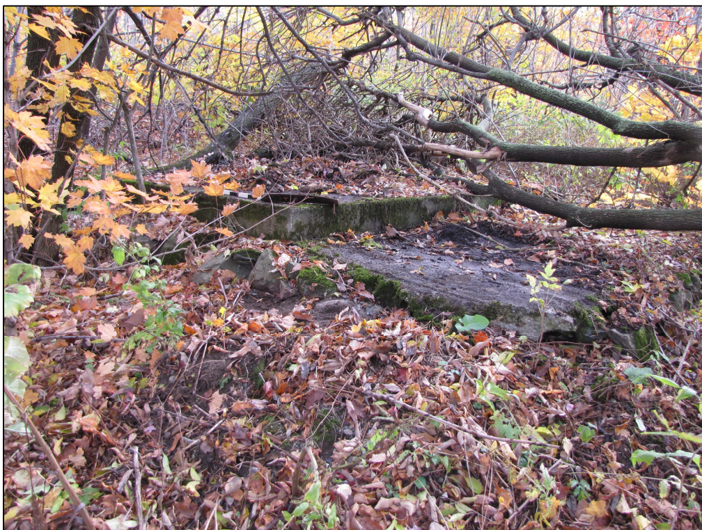
Photo 34 : Projet n° 154-09-0389, secteur 3, plate-forme de béton, chaînage 9+000, côté est de l'autoroute 73, municipalité de Sainte-Marie, direction sud-est (photo n° 154-09-0389-75)
