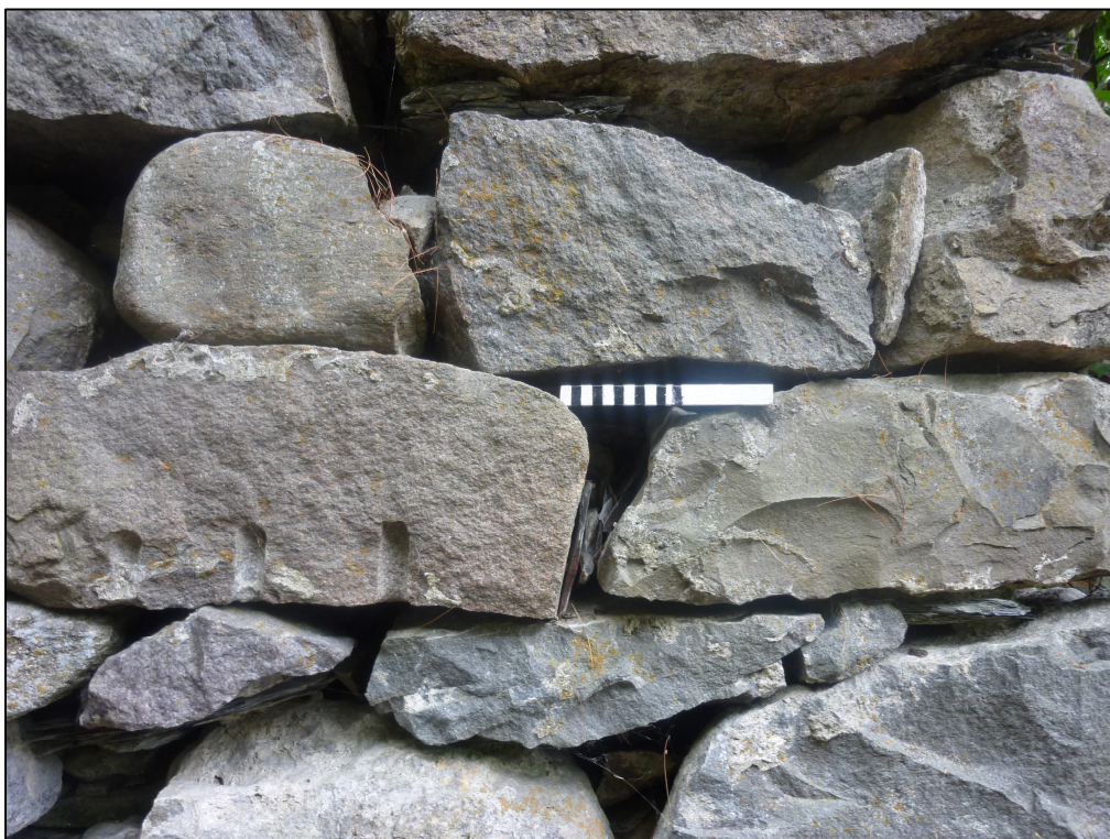
Photo 44 : Projet n° 154-09-0389, site CcEs-d, sous-opération 1A, détail du mur de fondation nord du moulin (1A200), direction sud (photo n° 154-09-0389-114)
