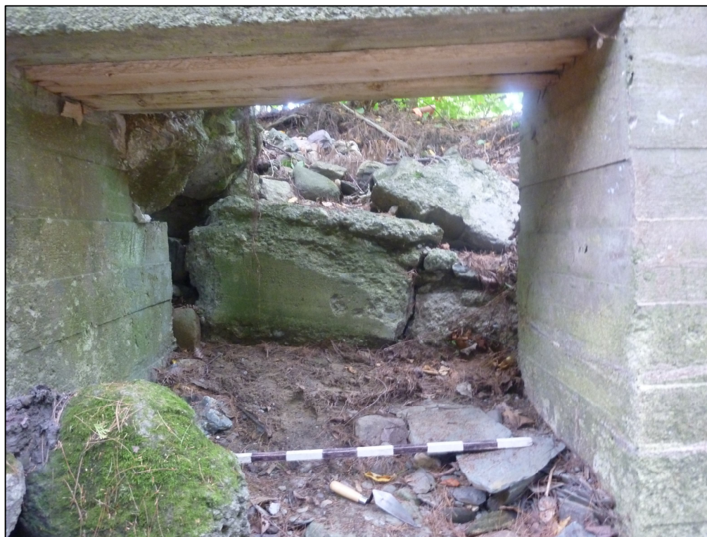
Photo 41 : Projet n° 154-09-0389, site CcEs-d, sous-opération 1A, détail de l'abée percée dans le mur de fondation est du moulin (1A100), direction ouest (photo n° 154-09-0389-95)
