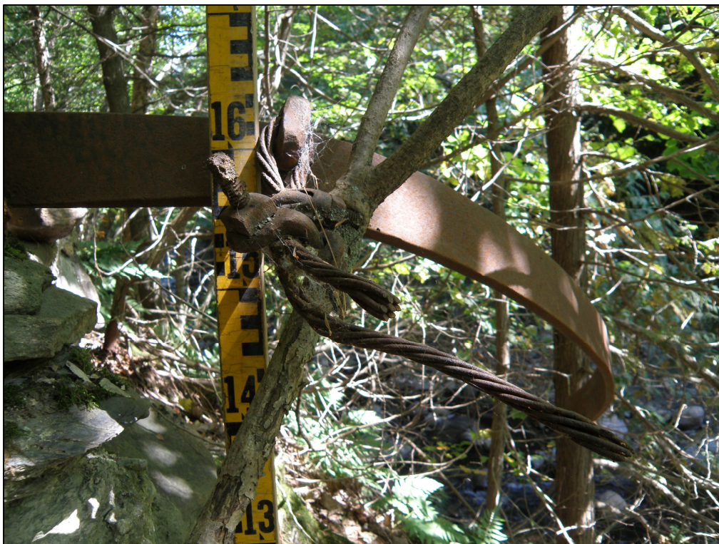
Photo 57 : Projet n° 154-09-0389, site CcEs-d, sous-opération 4B, structure maçonnée, direction nord-est (photo n° 154-09-0389-268)
