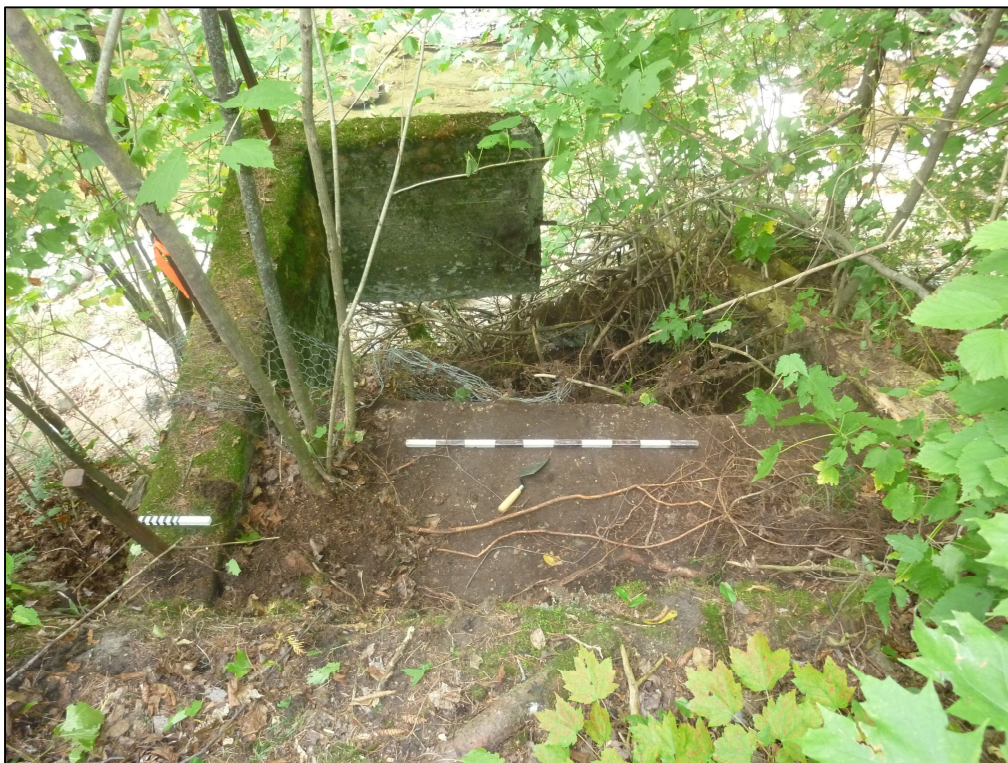
Photo 55 : Projet n° 154-09-0389, site CcEs-d, sous-opération 4A, aménagements de béton 4A100 et 4A200, direction nord-ouest (photo n° 154-09-0389-230)
