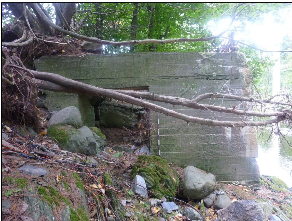
Photo 38 : Projet n° 154-09-0389, site CcEs-d, sous-opération 1A, mur de fondation est du moulin (1A100), direction ouest (photo n° 154-09-0389-89)
