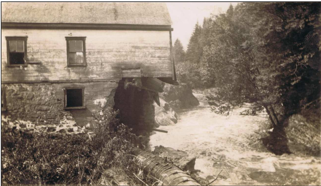
Photo 5 : Le moulin d'Arthur Chassé : coin du second moulin banal de la seigneurie de Taschereau sur la rivière Chassé, à Sainte-Marie, emporté par une crue causée par un embâcle de branches, vers 1937
