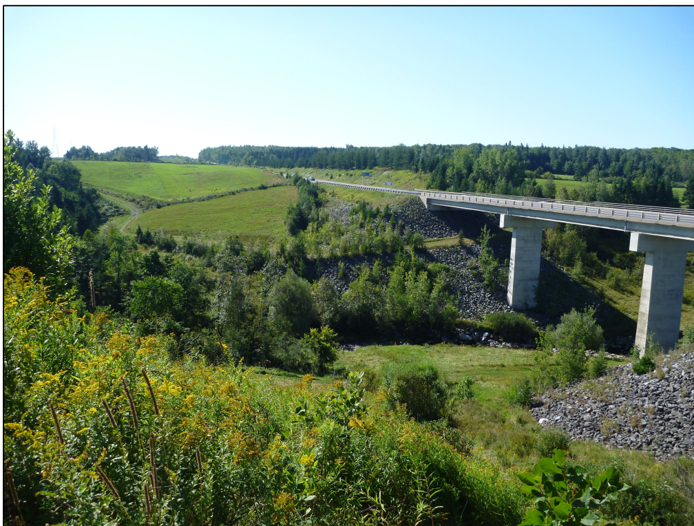
Photo 20 : Projet n° 154-08-0951, vue générale de l'emprise, chaînage 109+520, côté est de l'autoroute 73, municipalité de Saint-Joseph-de-Beauce, direction sud (photo n° 154-08-0951-04)
