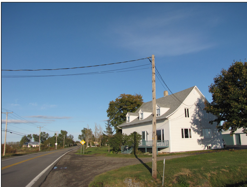
Photo 2 : Projet n° 154-04-0267, vue générale de l'emprise, secteur 2, chaînage 5+200, route 132, municipalité de Saint-Roch-des-Aulnaies, direction est (photo n° 154-04-0267-23)
