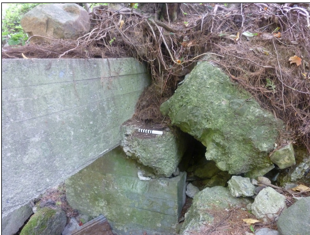
Photo 42 : Projet n° 154-09-0389, site CcEs-d, sous-opération 1A, aménagement lié à 1A100 à l'intérieur du bâtiment, direction sud-est (photo n° 154-09-0389-100)
