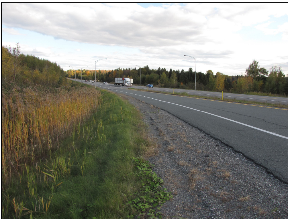
Photo 26 : Projet n° 154-09-0389, vue générale de l'emprise, secteur 1, chaînage 6+100, côté est de l'autoroute 73, municipalité de Sainte-Marie, direction sud (photo n° 154-09-0389-13)
