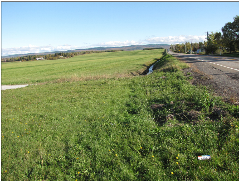
Photo 1 : Projet n° 154-04-0267, vue générale de l'emprise, secteur 1, chaînage 3+710, route de l'Église, municipalité de Saint-Roch-des-Aulnaies, direction sud (photo n° 154-04-0267-19)
