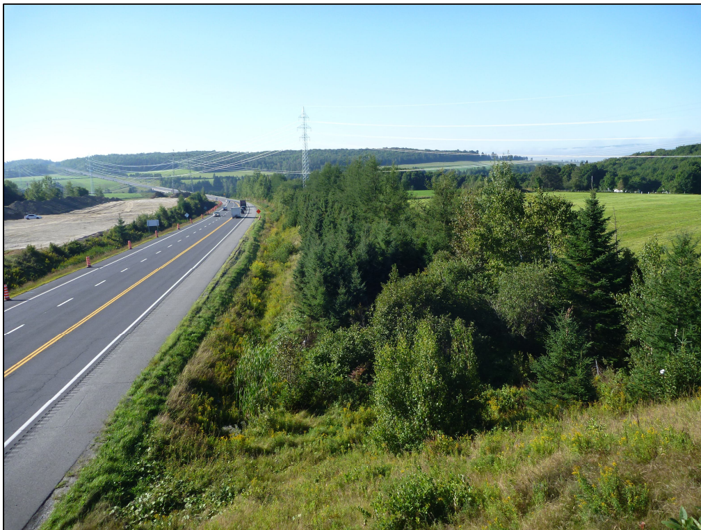
Photo 19 : Projet n° 154-08-0951, vue générale de l'emprise, chaînage 110+250, côté ouest de l'autoroute 73, municipalité de Saint-Joseph-de-Beauce, direction sud (photo n° 154-08-0951-81)
