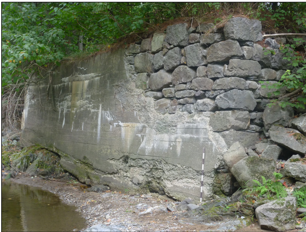
Photo 43 : Projet n° 154-09-0389, site CcEs-d, sous-opération 1A, mur de fondation nord du moulin (1A200), direction sud-est (photo n° 154-09-0389-118)
