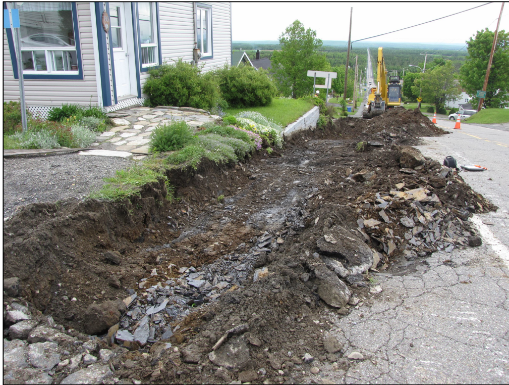
Photo 1 : Projet n° 154-03-0310, vue du roc affleurant, côté est de la rue Principale, chaînage 3+350, municipalité de Sainte-Sabine-de-Bellechasse, direction sud-est (photo n° 154-03-0310-08)
