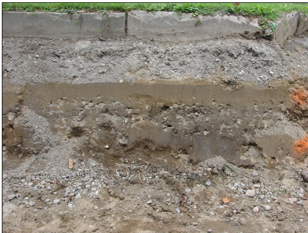
Photo 10 : Projet n° 154-08-0376, secteur 6a, paroi de l'excavation, côté sud de la route 132, municipalité de Leclercville, direction ouest (photo n° 154-08-0376-40)
