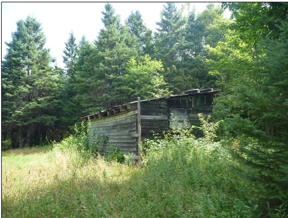
Photo 24 : Projet n° 154-82-0013, secteur 2, cabanon ou garage en bois, municipalité de Saint-Georges, direction est (photo n° 154-82-0013-55)
