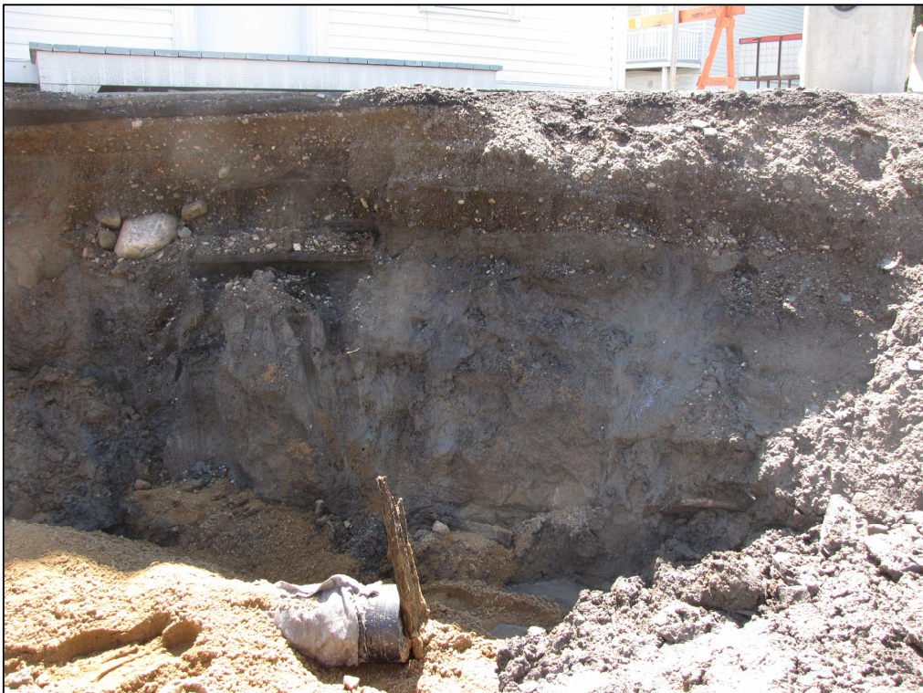
Photo 8 : Projet n° 154-08-0376, secteur 6, paroi de la tranchée d'excavation, chaînage 1+270, côté sud de la route 132, municipalité de Leclercville, direction sud (photo n° 154-08-0376-04)
