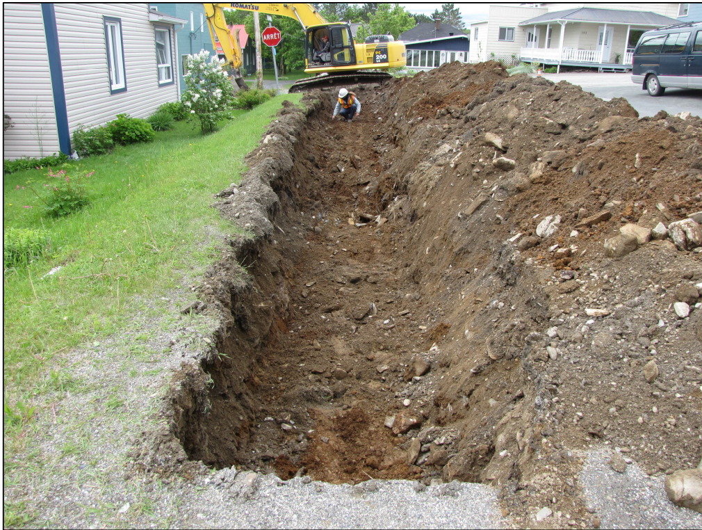
Photo 1 : Vue générale de la tranchée après excavation, à partir de sa limite est, côté sud de la rue de la Fabrique, direction ouest (photo n° 005)
