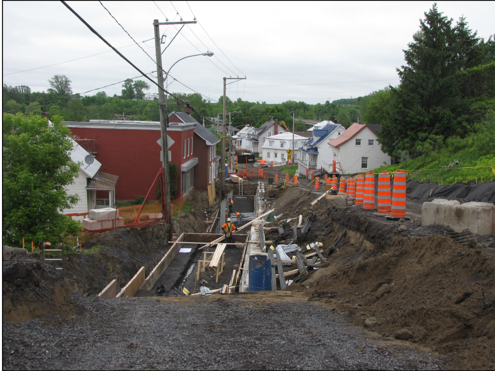
Photo 7 : Projet n° 154-08-0376, secteur 6, vue générale des travaux d'excavation et du mur de soutènement, chaînage 1+140, côté nord de la route 132, municipalité de Leclercville, direction est (photo n° 154-08-0376-
