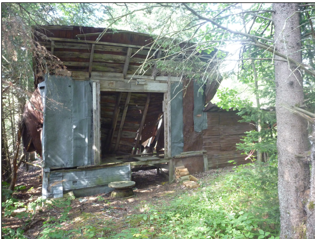
Photo 23 : Projet n° 154-82-0013, secteur 2, hangar de tôle sur charpente de bois, municipalité de Saint-Georges, direction ouest (photo n° 154-82-0013-50)
