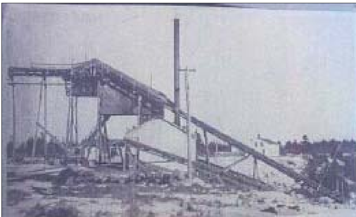
Figure 5 : Vue du système de convoyage, de chargement de wagons et de mise en pile du bois, vue vers l'est (Technisol, 2008 : 4)
