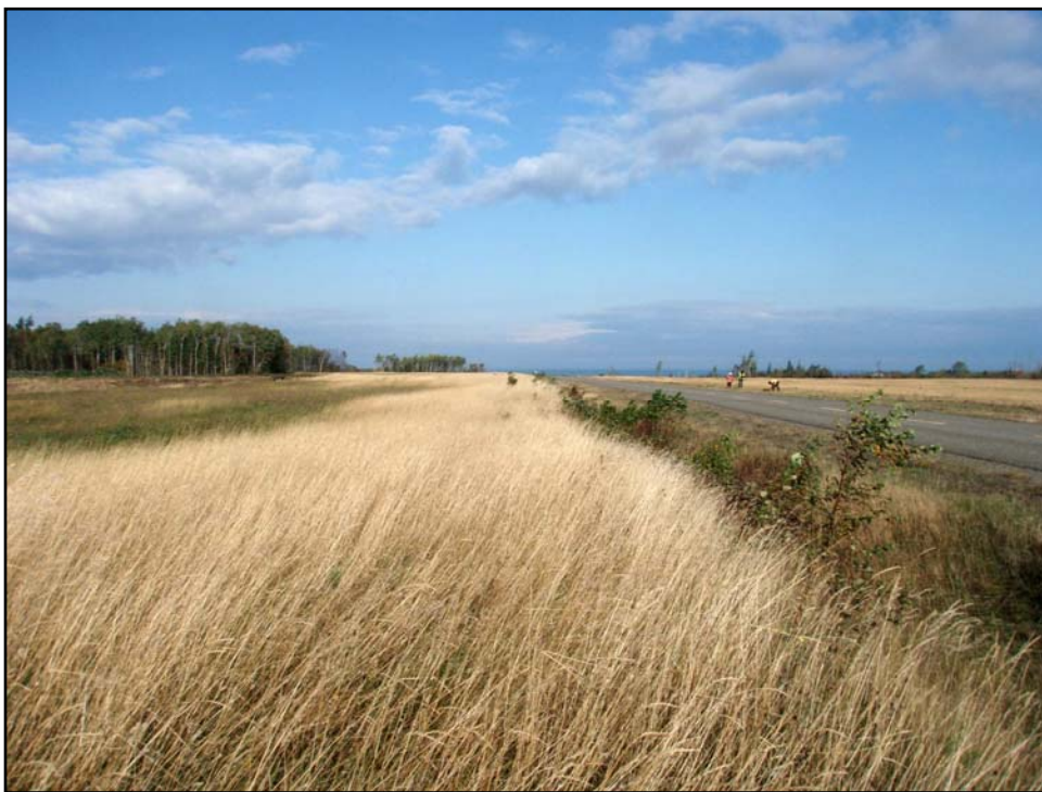
Photo 18 : Secteur 7, chaînage 60 + 000, vue générale du côté ouest de la route du 1 er -Rang, direction nord-ouest (154-90-0100-11-NUM1-38)
