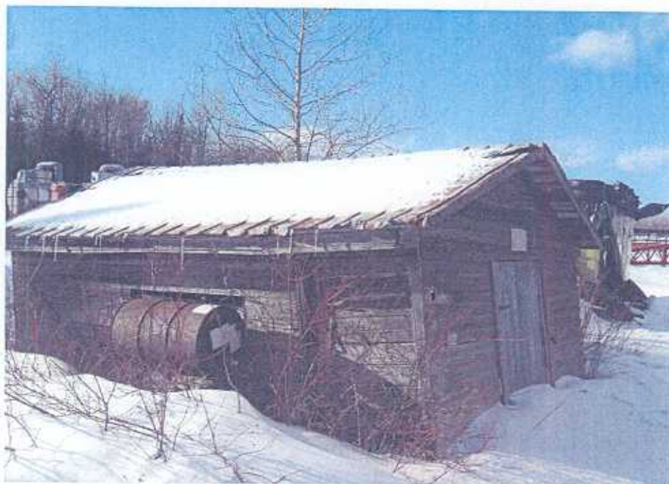
Photo 1 : Hangar désuet sans plancher ou dalle de béton pour l'entreposage actuel de diesel et d'huile mécanique usée (3 réservoirs de 205 L. en métal) avec tache noire au sol et également lieu d'entreposage d'essence dans le passé (Tourbière Réal Michaud et Fils inc.).
