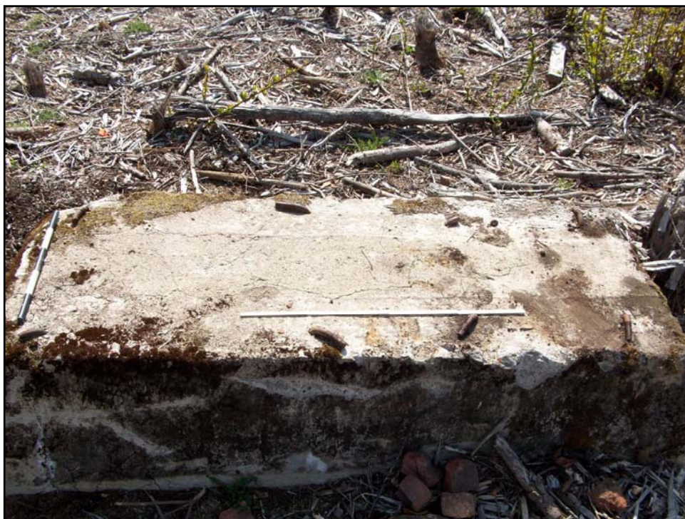
Photo 22 : Site CIEi-12, base de béton avec les boulons de fixation (CIEi-12-11-NUM1-14)
