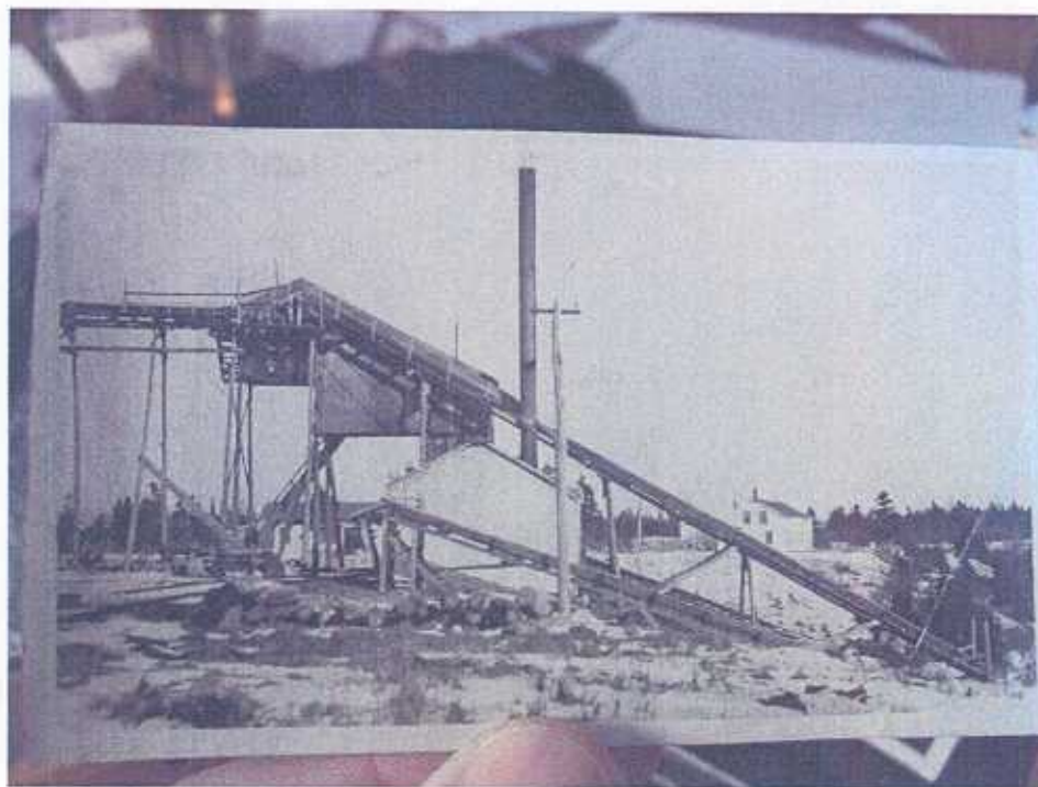
Photo 7 : Système de convoyage, de chargement de wagon et de mise en pile du bois (Lot-211-P)
