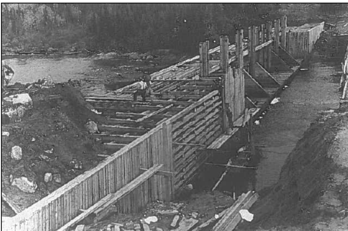
Figure 11 : « La construction d'une écluse à caisson » (Source : Société historique du Lac-Saint-Jean, F21, Fonds Price)
