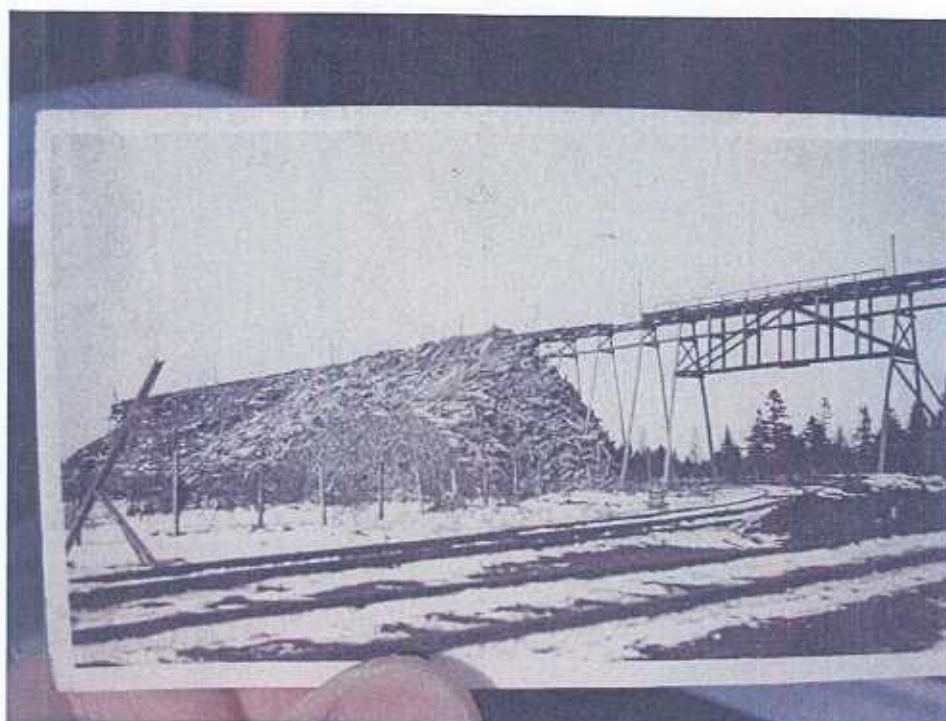
Photo 8 : Système de convoyage, de mise en pile et pile de bois (Lot-211-P)
