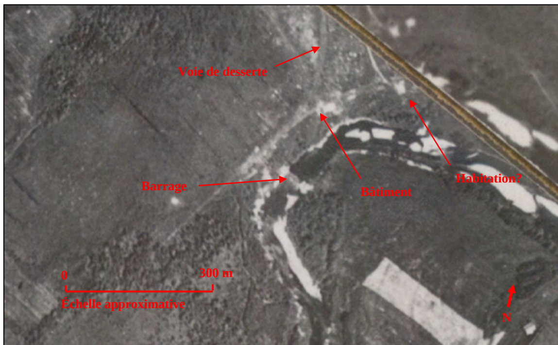
Figure 8 : Vue aérienne du site de transbordement en 1925 avec quelques éléments significatifs (Compagnie aérienne franco-canadienne, 1925).
