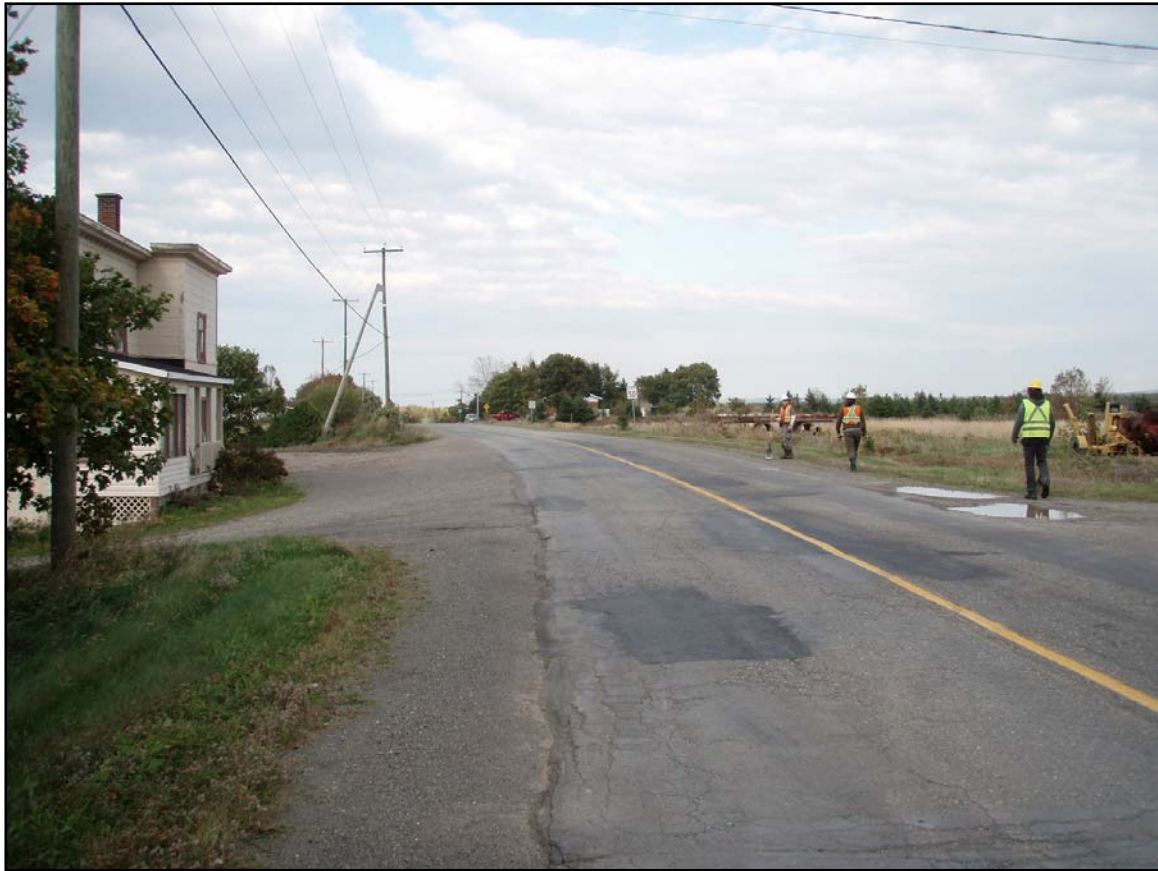
Photo 1 : Secteur 1, chaînage 90 + 400, vue générale du chemin du Coteau-du-Tuf, direction nord-est (154-90-0100-11-NUM1-52)
