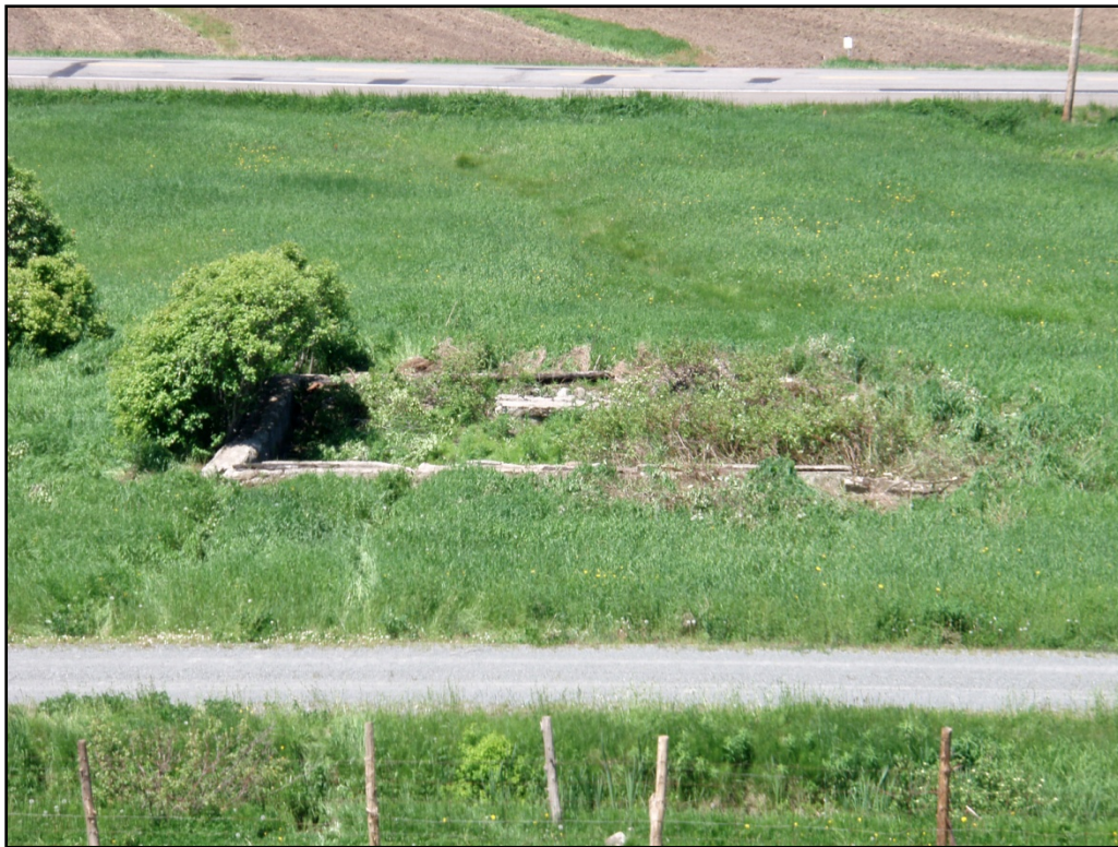
Photo 14 : Vestige 7, fondation en béton et en moellons, sous-opération 2E, direction nord (154-90-099-08-NUM1-24)
