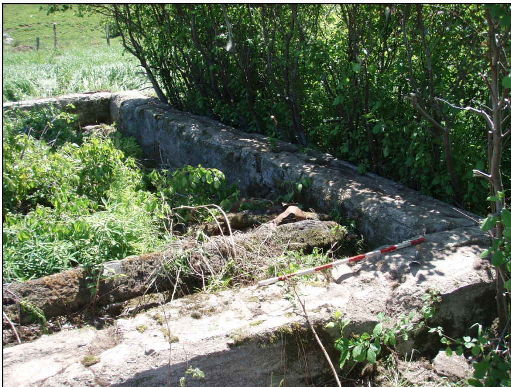
Photo 15 : Vestige 7, murs de fondation nord, sud et ouest d'un bâtiment, sous-opération 2E, direction sud-ouest (154-90-099-08-NUM1-19)
