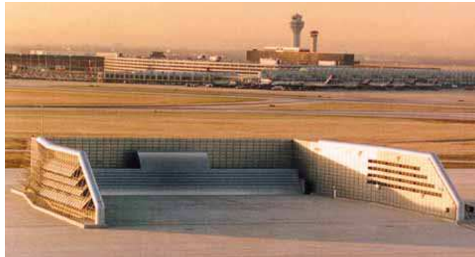
Figure 14 - Enceinte au sol à l'aéroport O'Hare, à Chicago, Illinois
