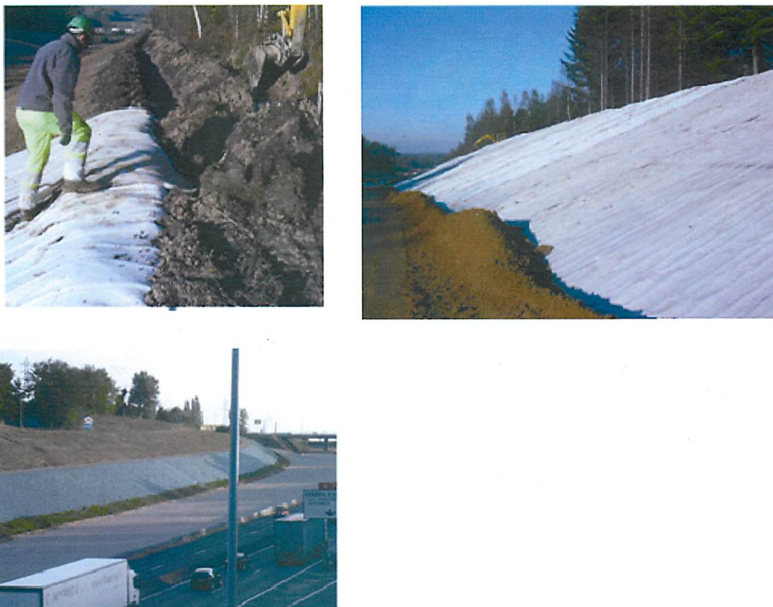
Figure 7.6 Exemples de masque drainant de rive.
