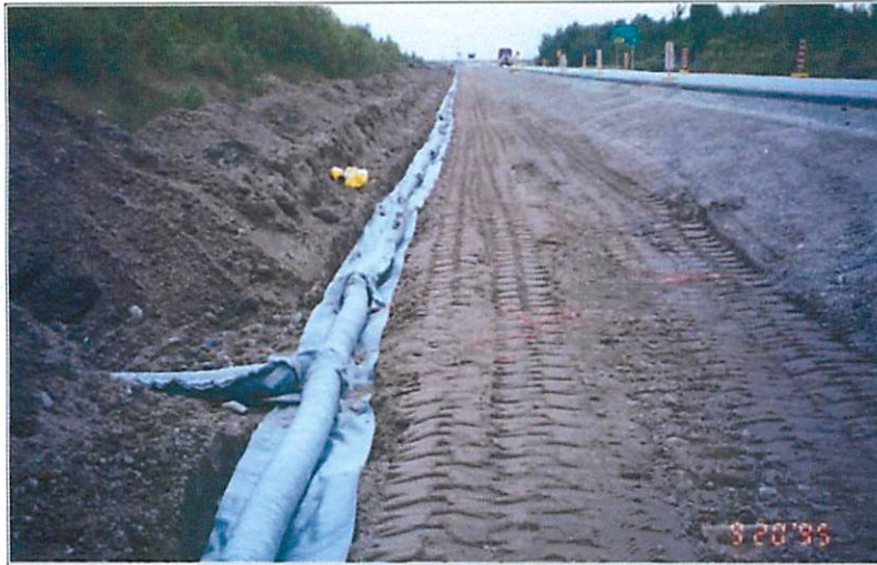
Figure 7.3 Tuyau de drainage à l'infrastructure.
