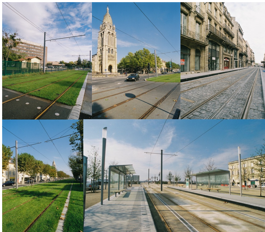
Figure 2.1 Exemples de revêtements de plateforme
