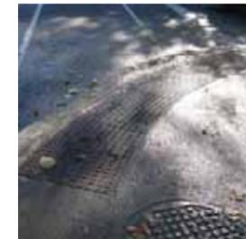
TAMPON ET BANDE PODOTACTILE EN FONTE, CARREFOUR ENTRE LA RUE PLAMENDON ET LE CHEMIN DE LA CÔTE-DES-NEIGES, MONTRÉAL
