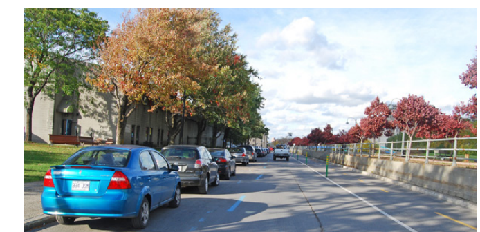
LE MURET SÉPARANT LA CHAUSSÉE DE LA PROMENADE ÉLEVÉE DU PARC
