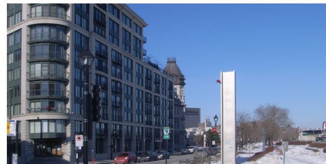
LE 1 RUE MCGILL, IMMEUBLE DE CONDOMINIUMS
