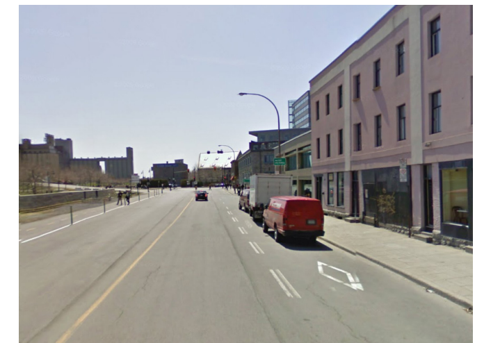
UNE VUE DE LA RUE DE LA COMMUNE OUEST, VERS L'OUEST
