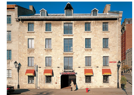
LE MAGASIN-ENTREPÔT ELIZABETH-MITTEBERGER-PLATT
