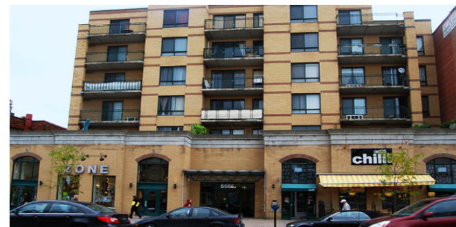
UN IMMEUBLE MIXTE RÉSIDENTIEL/COMMERCIAL
