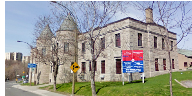
LA CASERNE CÔTE-DES-NEIGES
