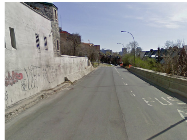
UNE VUE DU CHEMIN McDOUGALL, VERS LE SUD
