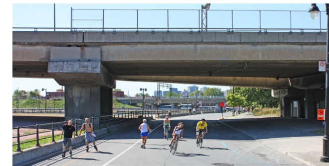
LA PISTE CYCLABLE QUI EMPRUNTE LA CHAUSSÉE DE LA RUE DE LA COMMUNE
