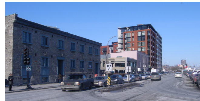
L'ENTREPÔT WILLIAM BUSBY LAMBE
