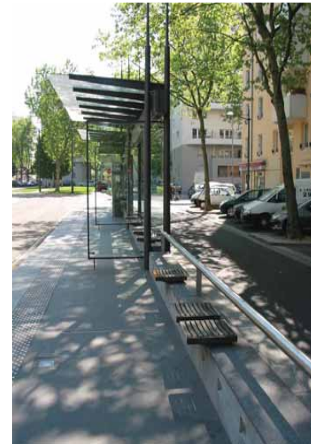
LYON - ASSISE BOIS SUR MURET EN BÉTON
