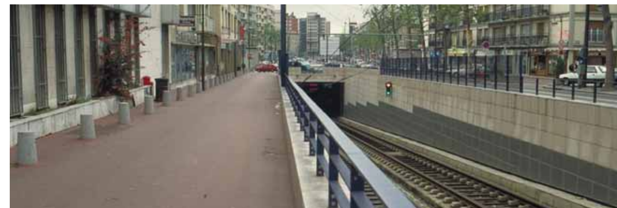
SI DES INTERVENTIONS DE CONCEPTEURS LUMIÈRE VALORISENT L'ESPACE SOUTERRAIN, LES TRÉMIES D'ACCÈS EN SURFACE PRODUISENT DES ESPACES EXCLUSIVEMENT FONCTIONNELS, EN OPPOSITION AUX ENJEUX DE QUALITÉ URBAINE PORTÉS PAR LES PROJETS DE
