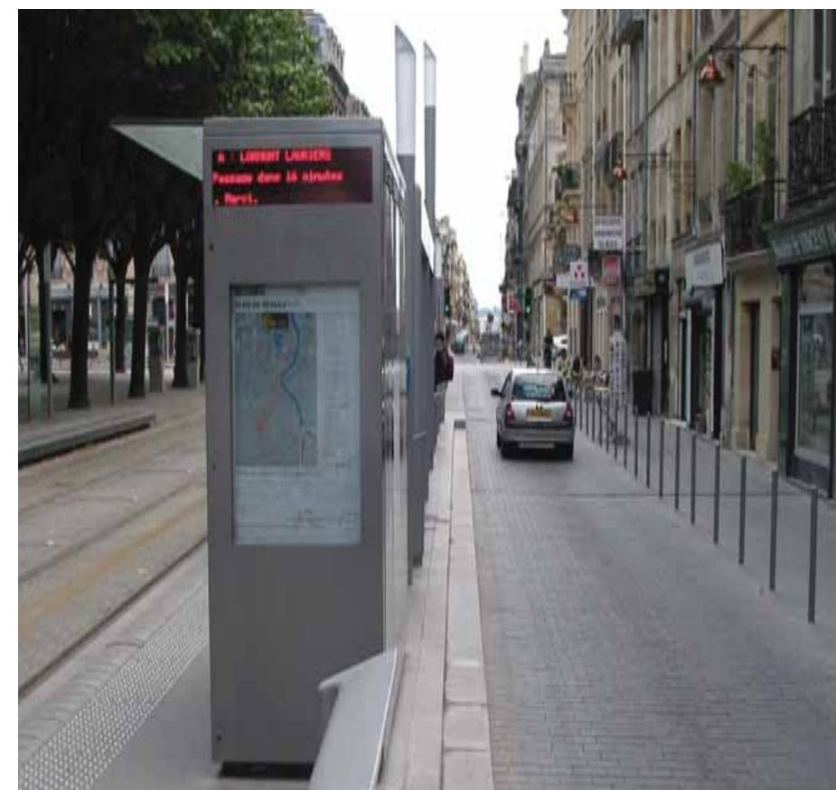
BORDEAUX - ARMOIRE TECHNIQUE AVEC SIGNALÉTIQUE LATÉRALE
