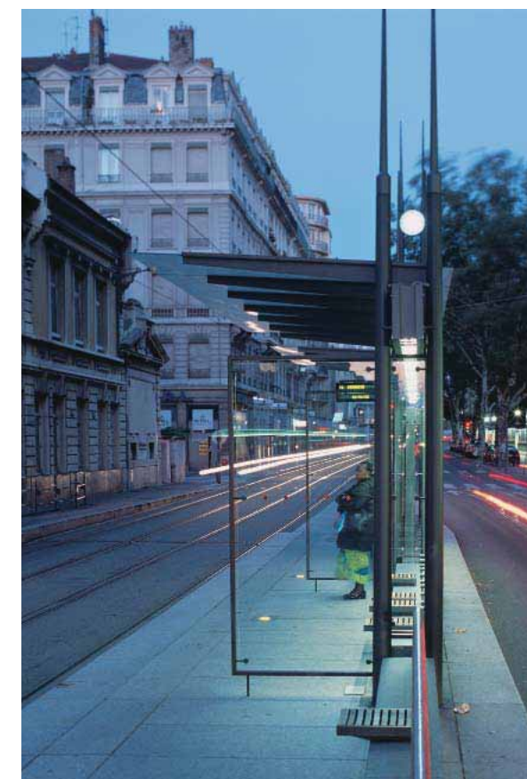
LYON POUR CERTAINES STATIONS, LE QUAI DE STATION EST MARQUÉ PAR UN DALLAGE DE GRANIT, DISTINCT DES SURFACES EXTÉRIEURES DE LA STATION : CHAUSSÉE EN ENROBÉ, TROTTOIRS COURANTS EN ASPHALTE, SITE PROPRE EN BÉTON DÉSACTIVÉ
