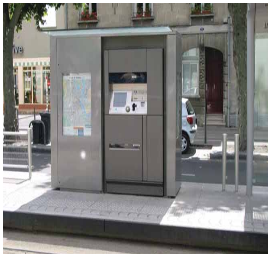
BORDEAUX- ARMOIRE TECHNIQUE DE QUAI, BILLETTERIE ET ARMOIRE TECHNIQUE INTÉGRÉE
