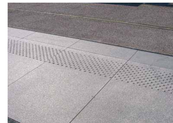
MULHOUSE DALLES DE QUAI EN GRANITE AVEC PLOTS PODOTACTILES ISSUS DE LA PLEINE MASSE DE LA PIERRE
