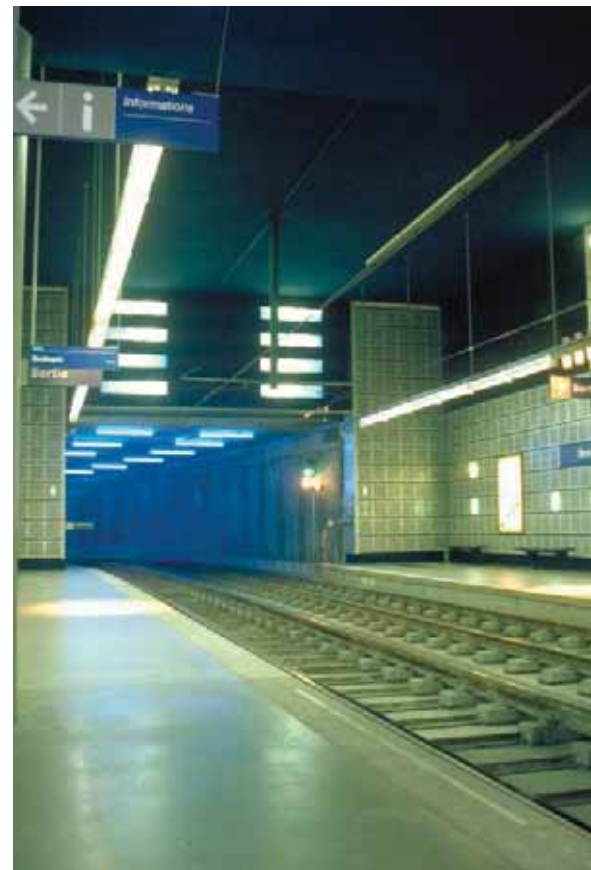
STATIONS SOUTERRAINES DU RÉSEAU DE ROUEN
