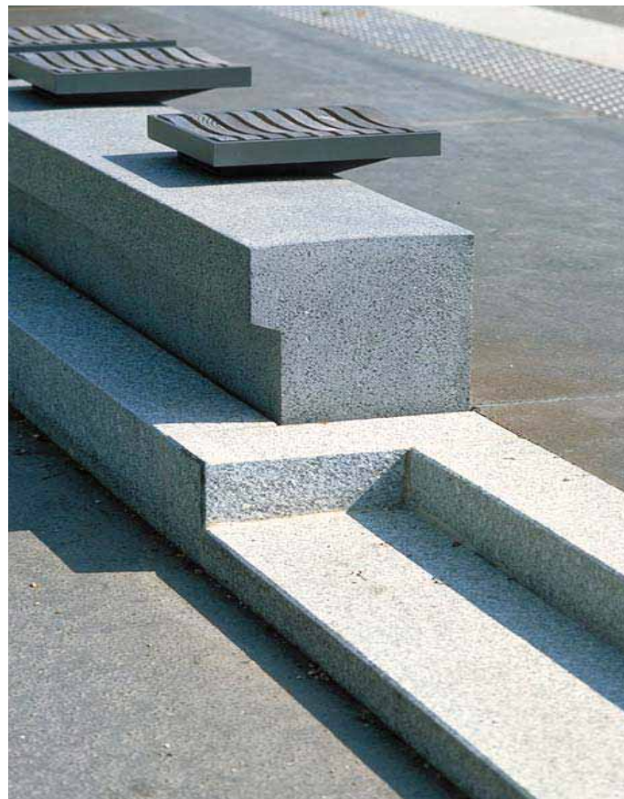
LYON - MURET EN BÉTON PRÉFABRIQUÉ
