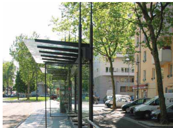
LYON - ABRI DE QUAI
