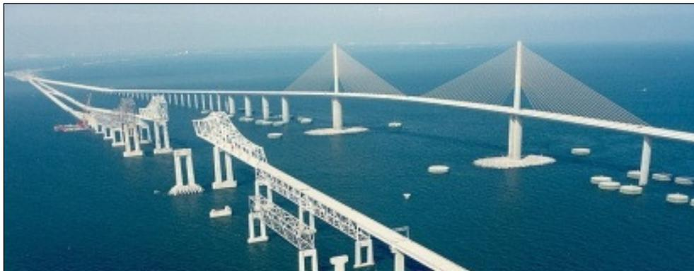
Cette méthode de déconstruction du pont utilise des barges pour accueillir les différents éléments du pont existant détaché, pour permettre leur sciage et pour récupérer les déchets de démolition. Contrairement à la méthode de démolition par explosion contrôlée, cette approche permet une maîtrise en tout temps des matériaux issus de la démolition du pont existant.
