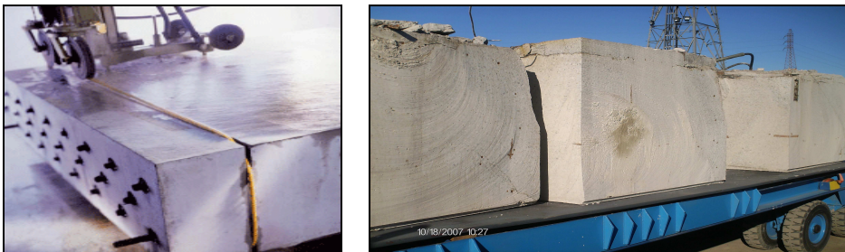
Figure 47 – Exemple de sciage et de transport des blocs de béton
