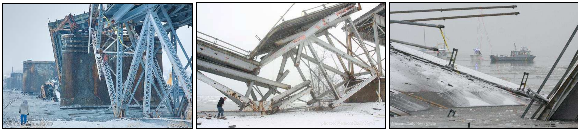
Figure 55 – Exemple de démolition par explosion : Cooper River Bridge
