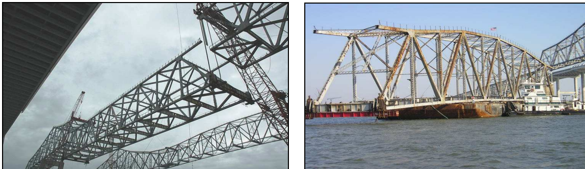
Figure 37 – Exemple d'opération de démontage et de transport d'une travée
