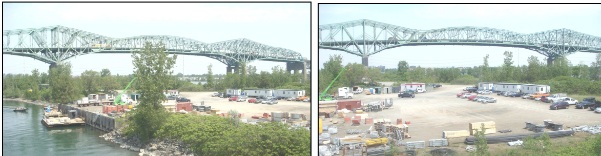
Figure 32 – Jetée de la voie maritime : Vues d’ensemble
