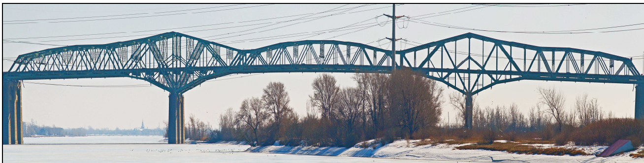
Figure 49 – Vue des travées au-dessus de la Voie maritime
