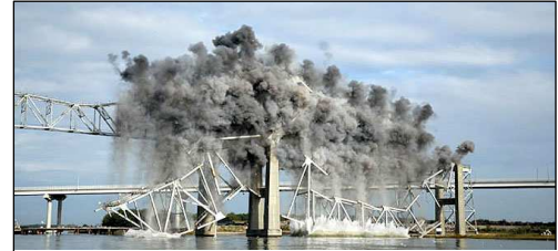
Figure 53 – Exemple de démolition par explosion
