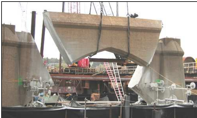
Figure 45 – Exemple de sciage des chevêtres
