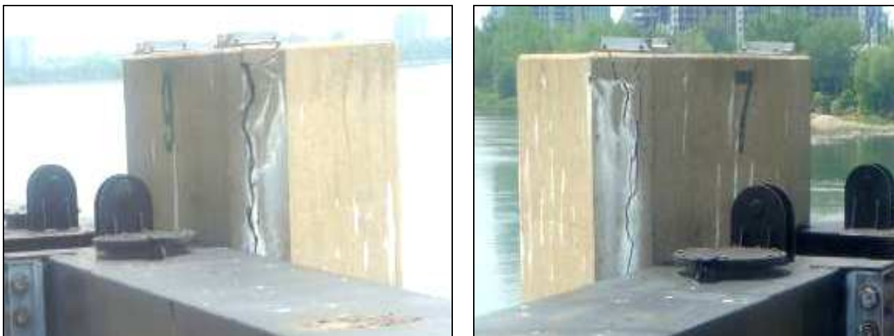
Figure 3 – Piliers de l'Estacade
