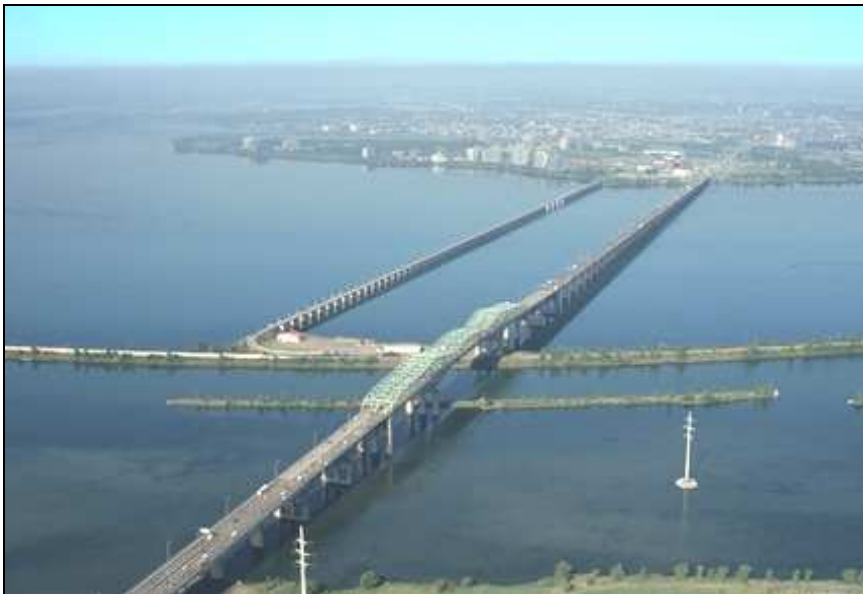
Figure 1 – Vue du Pont Champlain et de l'Estacade
