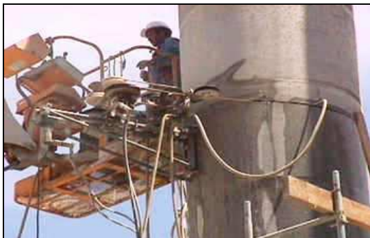
Figure 46 – Exemple de sciage des piles
