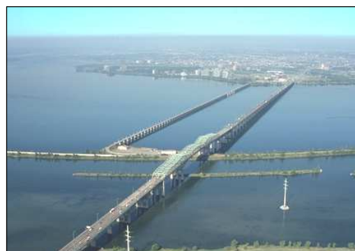
Figure 27 – Vue d'ensemble du Pont Champlain
