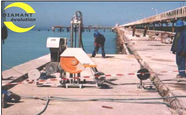
Figure 44 – Exemple de sciage d'une section du tablier
