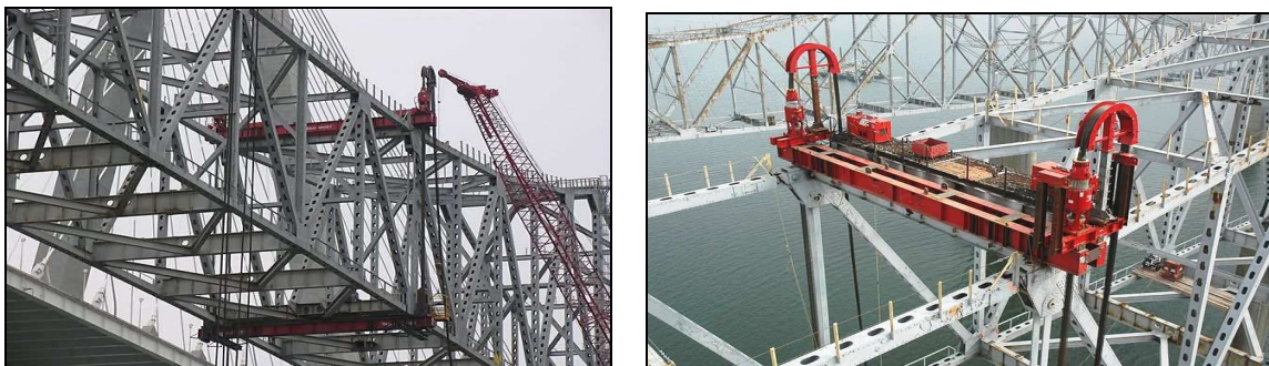
Figure 36 – Exemple d'installation de support-levage de type « strand jacks »
