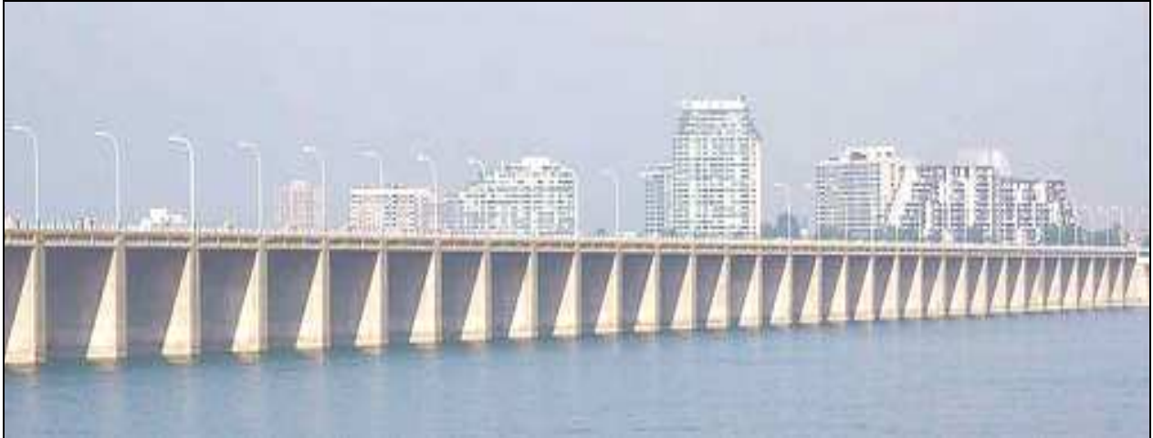
Figure 2 – Vue de l'Estacade
