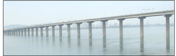
Figure 20 – Série des piles du Pont Champlain
