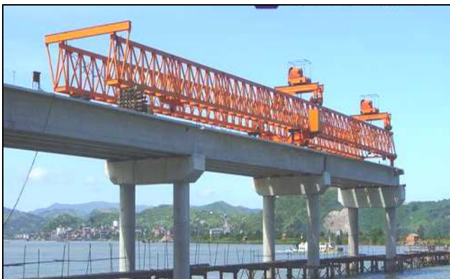
Figure 43 – Exemple d'opération d'une ferme de lancement
