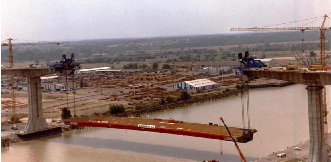
Il est aussi possible de décomposer l'opération en hissant plusieurs éléments de tablier, de plus petite taille et de poids plus faible.
