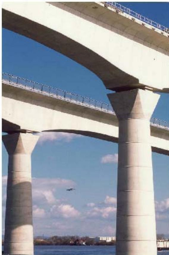
**2.3.** La solution 1B est un pont en caisson à hourdis nervuré. Les nervures sont de préférence précontraintes, et le hourdis travaille en béton armé dans le sens longitudinal sous les charges locales, de nervure à nervure.
