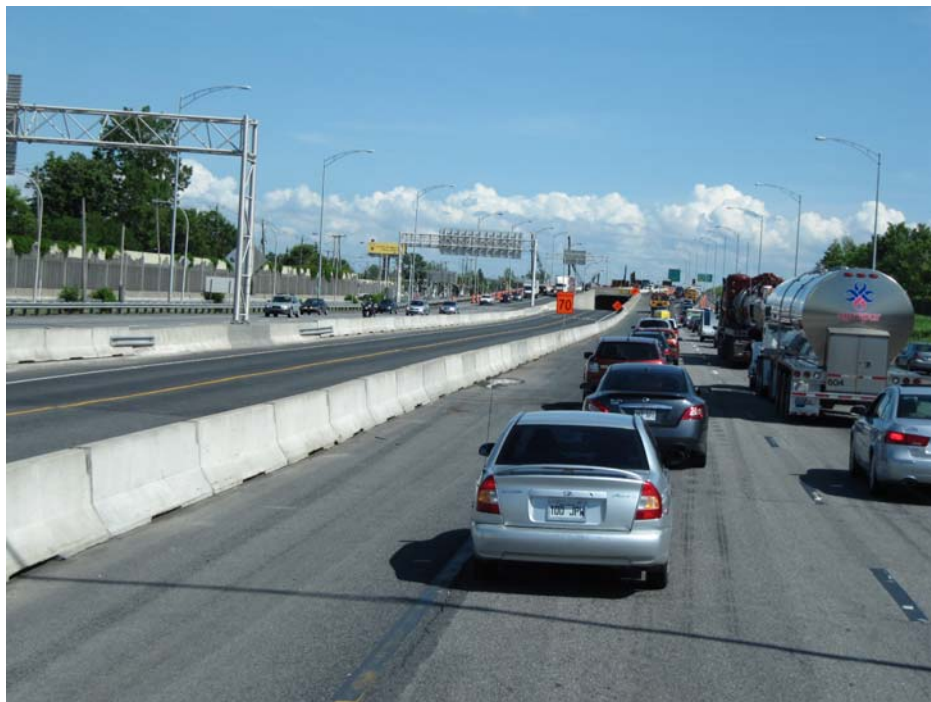
Photo 2 : Voie bidirectionnelle sur la Rive-Sud en site propre au centre de l'A-10
