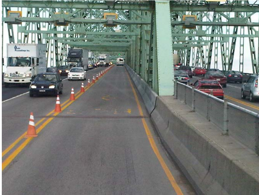
Photo 1 : Voie réservée sur le tablier du pont Champlain en direction de la Rive-Sud
