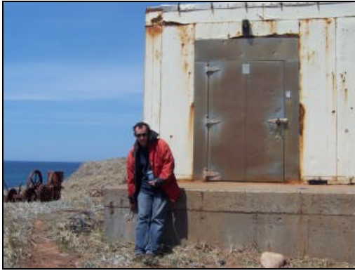
Figure 13 – Emplacement du repère de nivellement matricule 85L9207 de la Pointe-aux-Loups. Source : Service hydrographique du Canada
