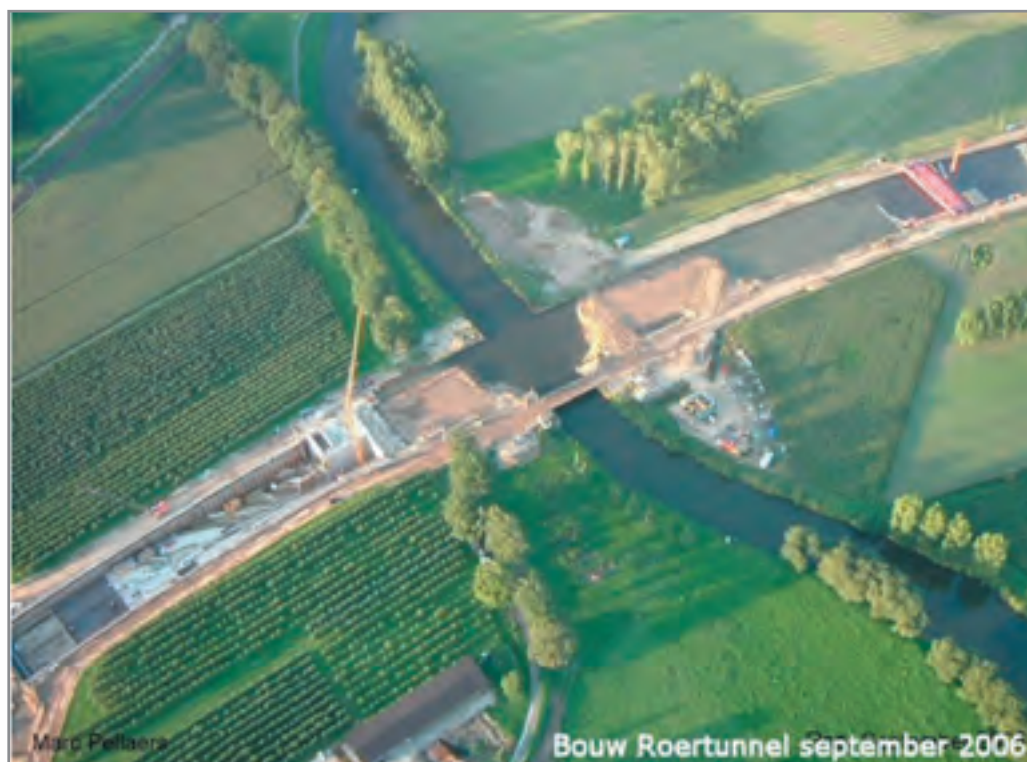
Photo du tunnel en chantier pour la Roer
