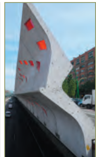
1. Profil en travers montrant que par leur forme en «coquille» les protections phoniques sont adaptées à l'environnement des immeubles hauts de logement qui bordent les deux côtés de la voie. 2. La voie rapide elle-même, les écrans et les passerelles de traversée (rues ou passages piétons). Une esthétique moderne et colorée a été recherchée pour ces ouvrages techniques. 3. L'espace public redonné aux habitants de la proximité : plantations, bancs, aménagements ponctuels dédiés à des groupes d'utilisateurs : jeux d'enfants, terrains de boules, parterres fleuris et bancs ... 4. détail sur la structure anti-bruit.
