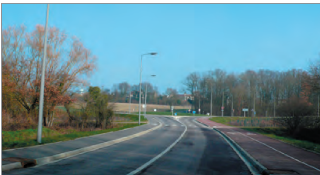
Le nouveau giratoire vu depuis la rue de la Côte des Auges en venant de Menucourt et en arrière-plan les toits de Courdimanche. 135
