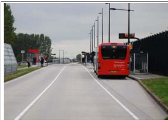
Zuidtangent: voie de dépassement pour quelques quais
