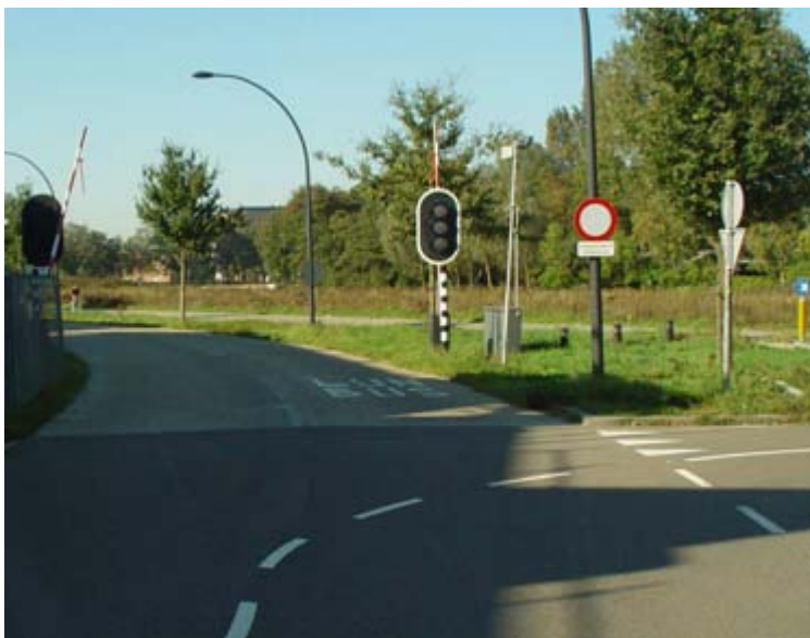
Twente ; contrôle d'accès avec barrières et feu tricolore
