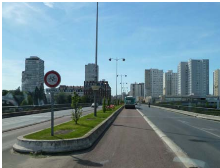
Sud parisien : le Trans-Val-de-Marne (TVM), première ligne périphérique très empruntée, ici au niveau de l'ancienne portion inaugurée en 1993
