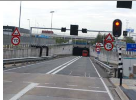
Zuidtangent: type A, l'entrée dans le plus long tunnel sous le tarmac (1,4 km)
