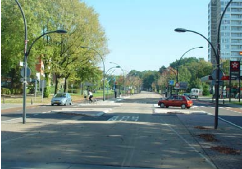
Twente : Voie unique dans le carrefour
