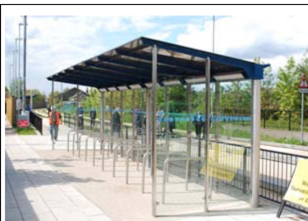
Cambridge: un quai large incluant une forte intermodalité vélo avec abri
