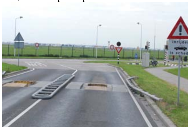
Zuidtangent : protection de la voir réservée - (également observée à Almere et à Jönköping)
