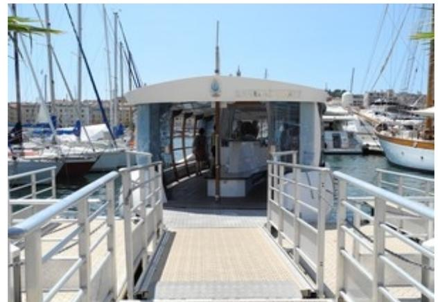
Illustration 11 : Ponton dépliant et palette d'accessibilité à l'embarcadère du Ferry-Boat
