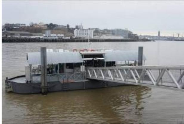
*Illustration 12 - Nantes, ponton de Trentemoult, à marée basse l'inclinaison de la passerelle est plus importante
