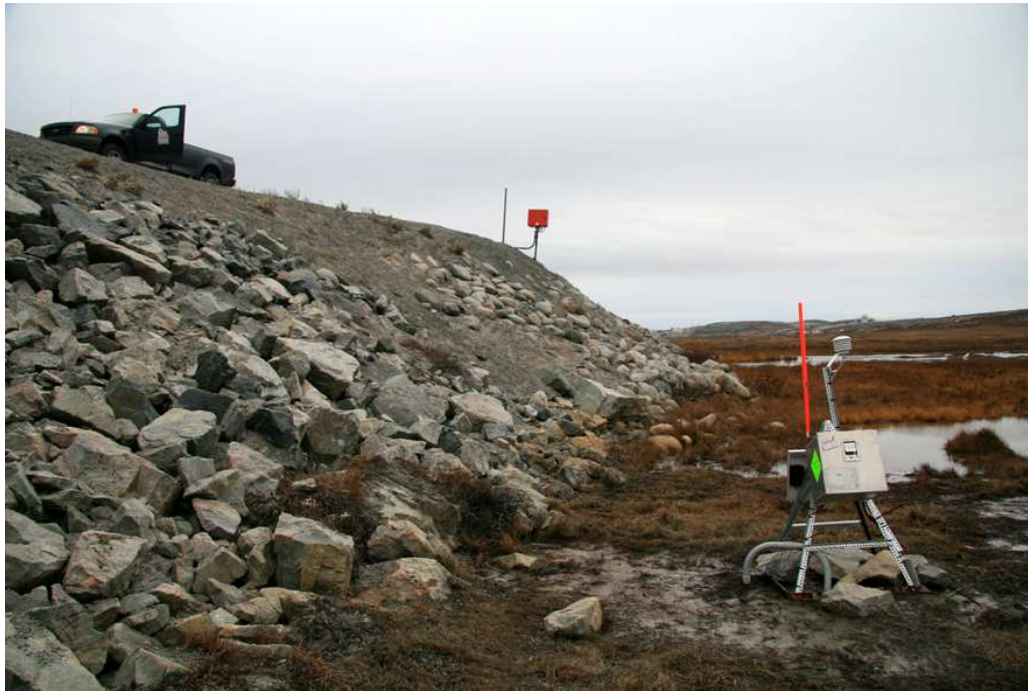
Figure 2 Station d'Inukjuak au pied du remblai de la piste.
