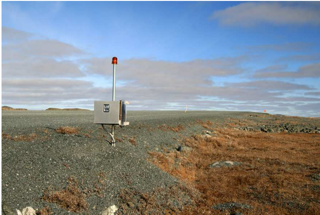
Figure 39 Station automatisée HT-183 sur le remblai de piste d'Akulivik.
