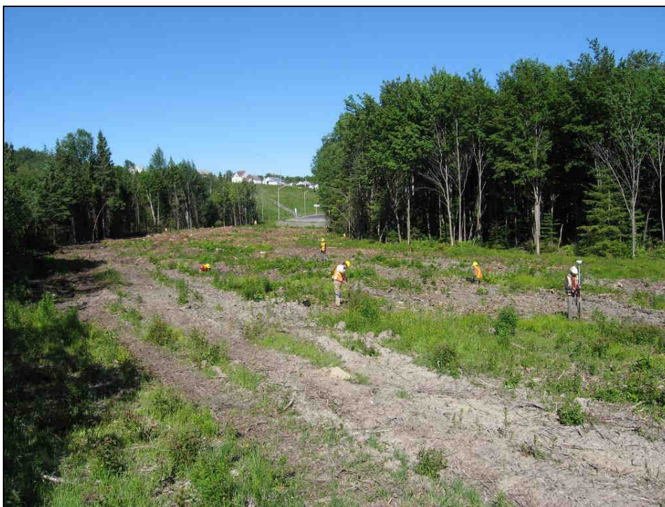
Photo 1 : Emprise du secteur 1 (ch 11+570), zone défrichée dans une ancienne tourbière, direction ouest (photo # 154-02-2011-9)
