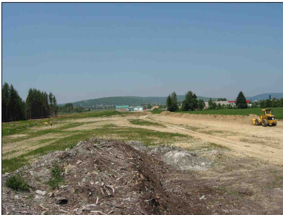
Photo 5 : Emprise du secteur 2 (ch 13+180), perturbations, direction nord (photo # 154-02-2011-36)
