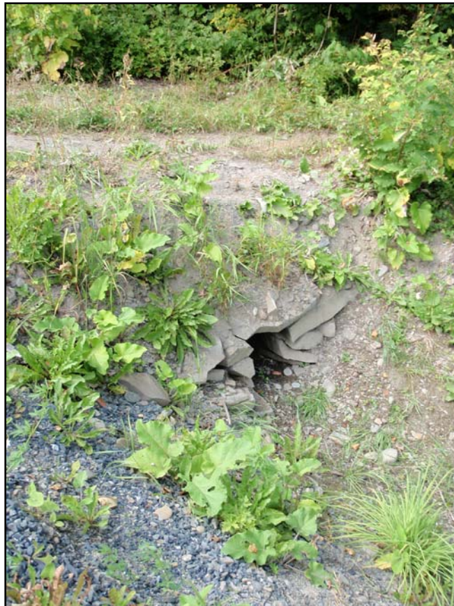
Photo 8 : Ponceau en pierre et fossé du côté nord du chemin de la Traverse, direction ouest (154-01-0055-10-NUM1-9)
