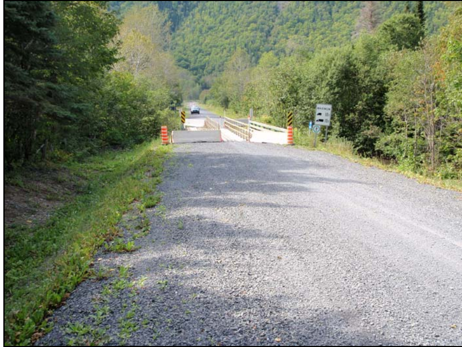
Photo 7 : Emprise du projet et pont P-02715, direction ouest (154-01-0055-10-NUM1-6)
