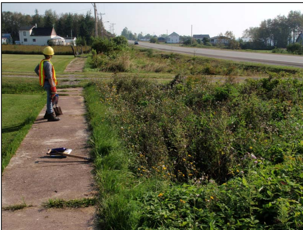
Photo 23 : Trottoir de béton et large fossé, côté nord de la route 132, direction est (154-09-0297-10-NUM1-15)
