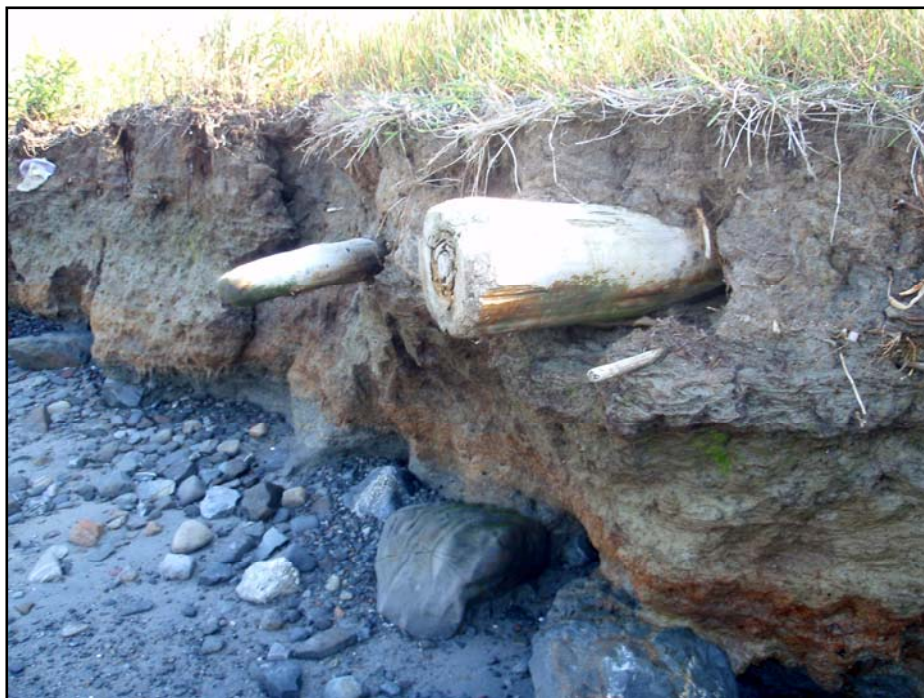
Photo 3 : Érosion de la berge et billots enfouis, direction nord-est (154-07-0350-10-NUM1-25)
