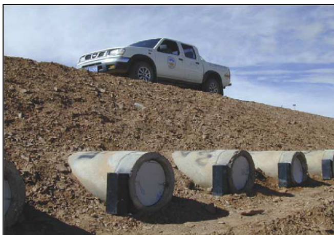
Figure 15. Installation de bouchons sur des conduits d'air transversaux le long du Qinghai-Tibet Railway (tiré de Guoyu et coll., 2005)
