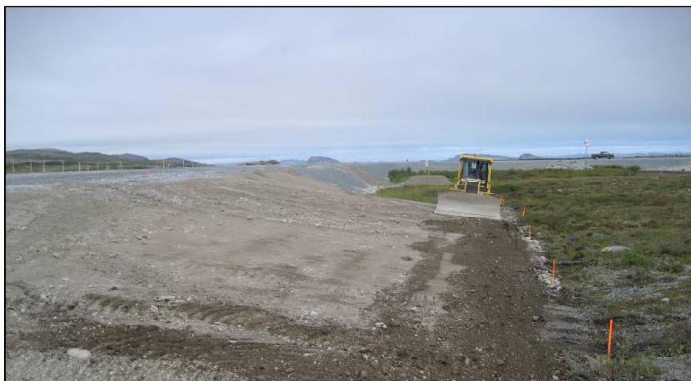
Figure 21. Adoucissement de la pente 1V : 8H sur le site de Tasiujaq (Lemelin et coll., 2008)
