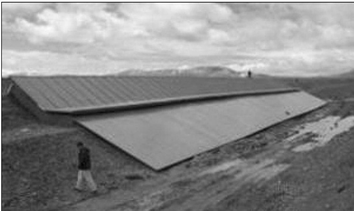
Figure 13. Ecran solaire / neige le long du projet Qinghai -Tibet Railway (modifié de Cheng et coll., 2007)
