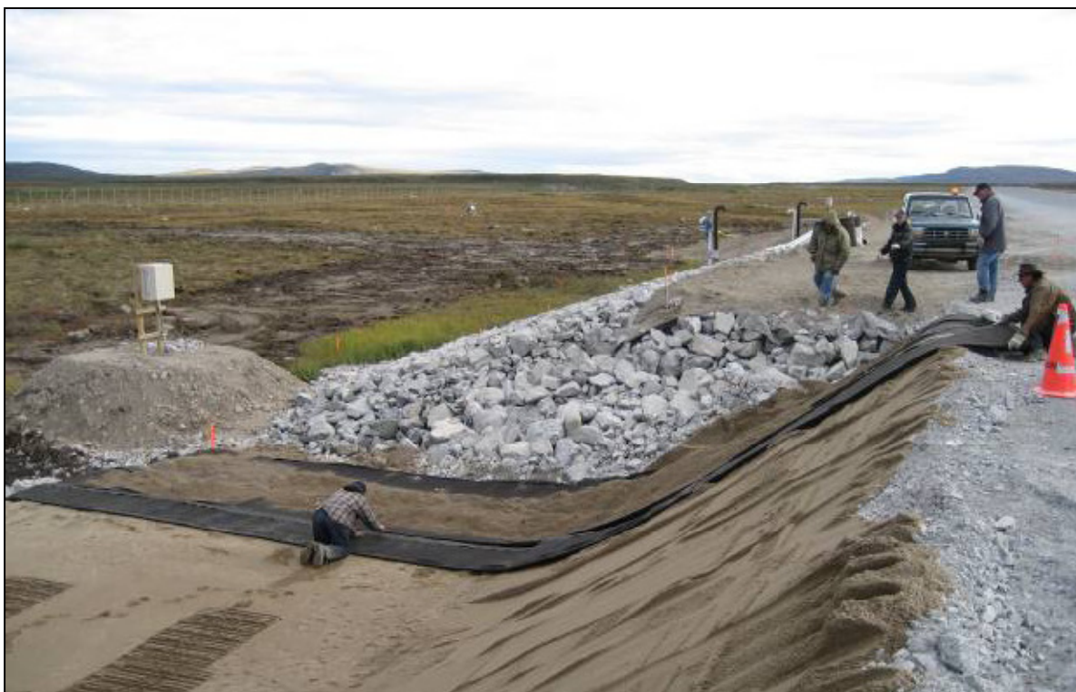
Figure 20. Mise en place du géocomposite dans l'épaule du remblai de Tasiujaq (Lemelin et coll., 2008)
