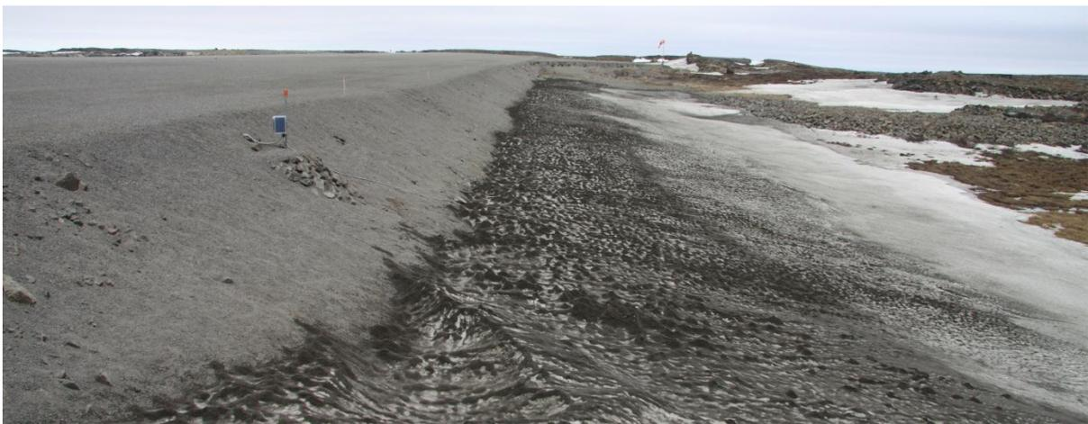
Figure 44 : Accumulation de neige importante en bordure de piste sur le côté est entre les chaînages 6+190 m et 6+280 m.
