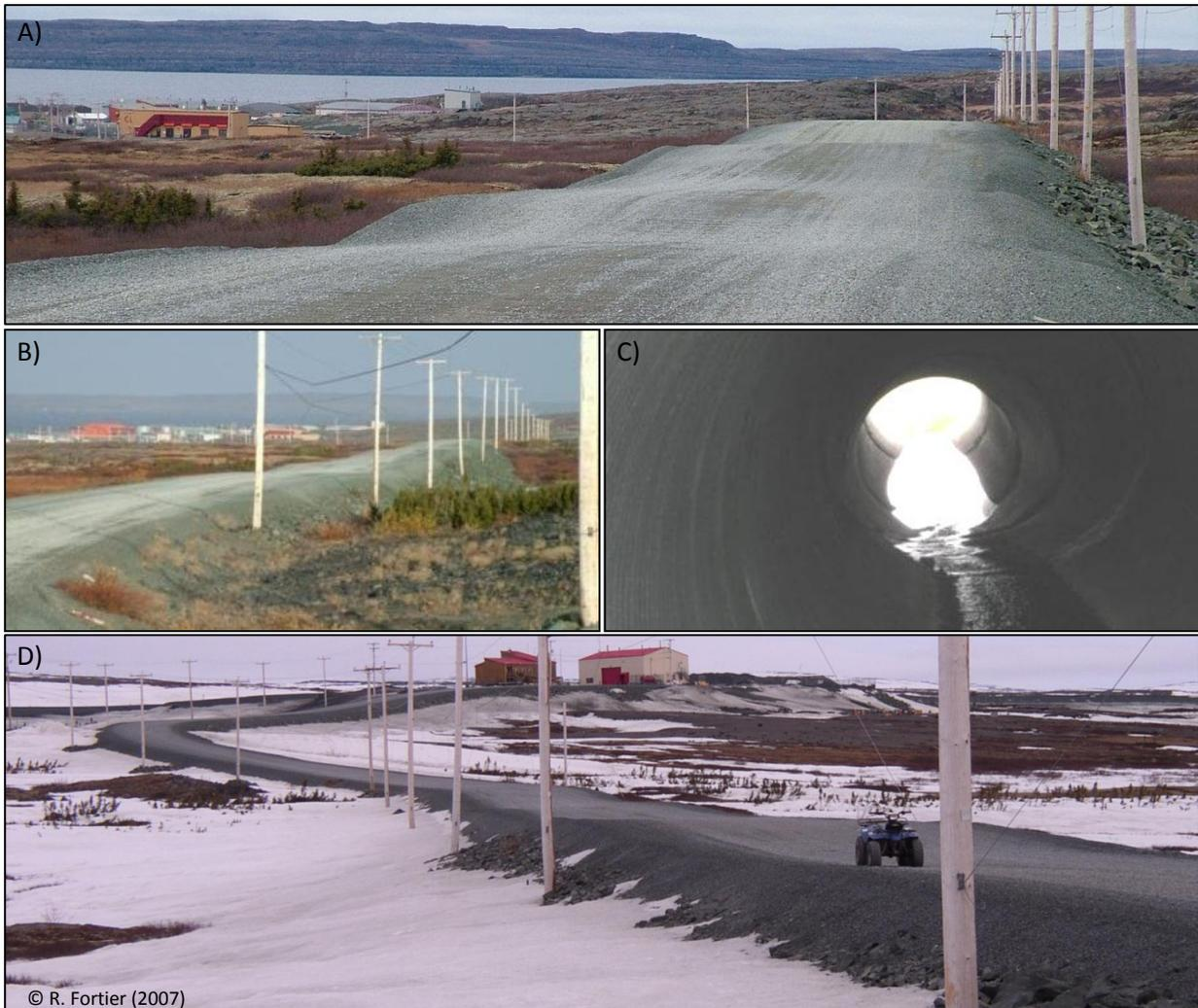
Figure 18: A) et B) Tassements différentiels le long de la route d'accès à l'aéroport d'Umiujaq liés à la dégradation du pergélisol, été 2008. C) Ponceau déformé suite aux tassements. D) Accumulation de neige de chaque côté du remblai en date du 30 avril 2007 (Tirée de Fortier et Bolduc, 2008).
