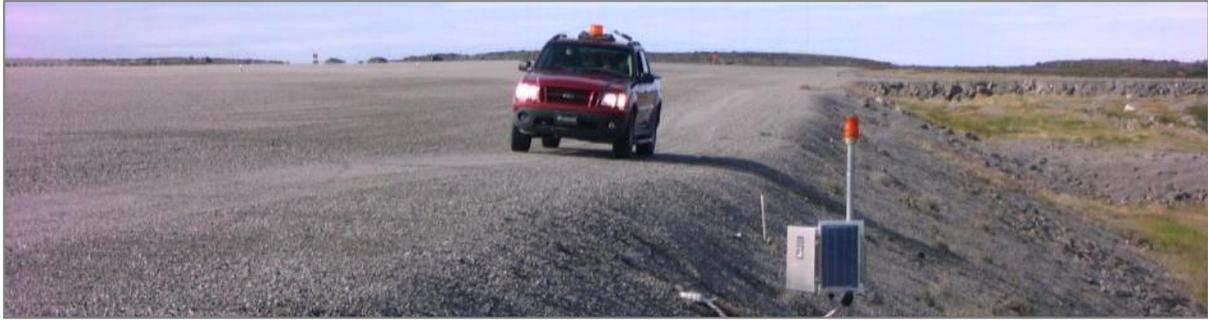
Figure 42 : Dépression majeure relevée en bordure de piste sur le côté est entre les chaînages 6+190 m et 6+280 m.
