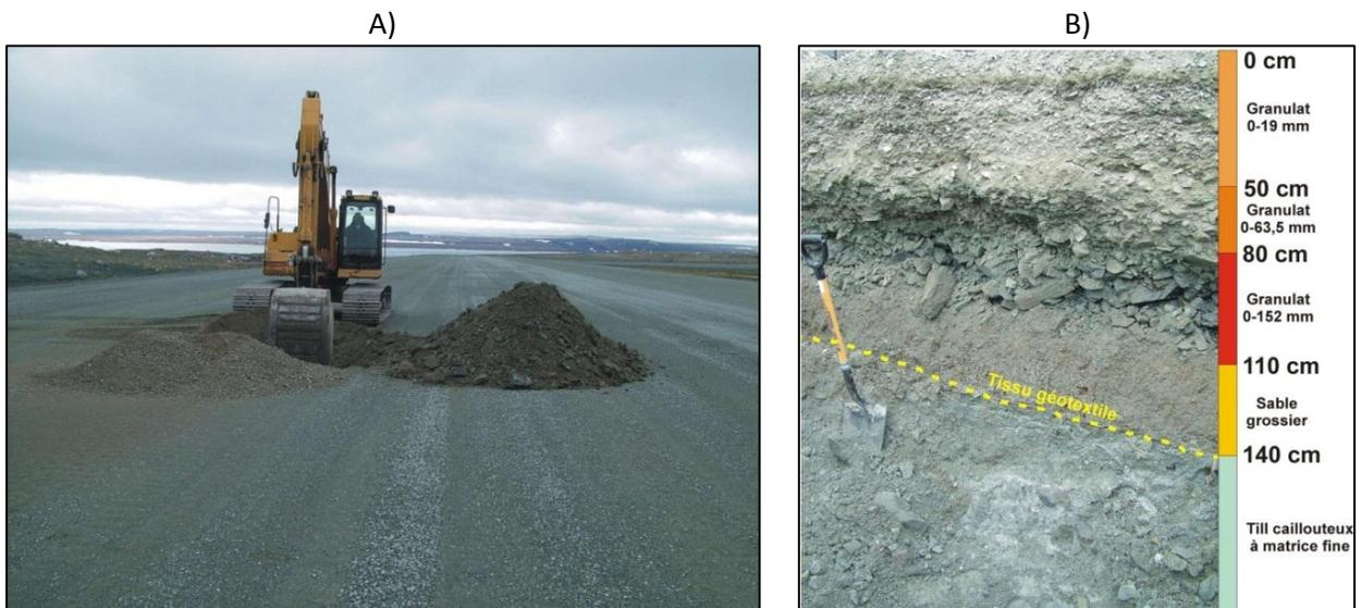
Figure 92: Stratigraphie du remblai et du terrain naturel sus-jacent tel qu'observé lors de l'excavation réalisée en 2005 par Allard et al. (2007).
