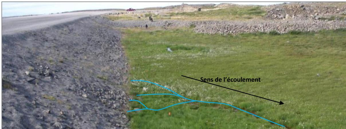
Figure 43 : Écoulement d'eau sous la piste vis-à-vis le centre de la dépression majeure côté est.
