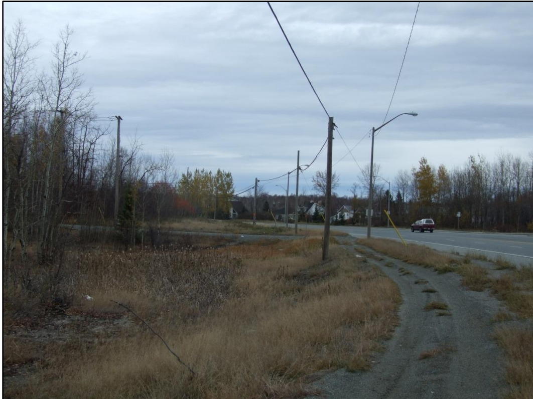
Photo 1 Chaînage 0+100, direction nord
