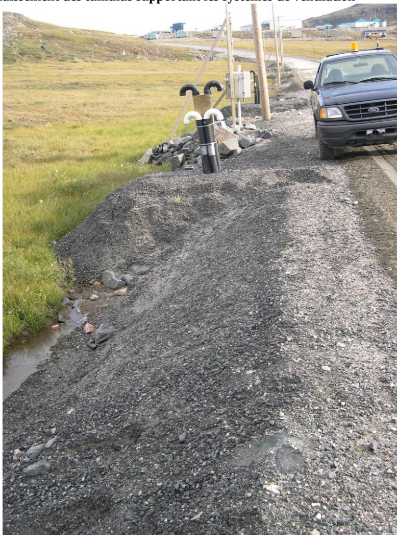
Figure 5-7 : Accumulation d'eau au pied du talus de la section avec drain thermique
