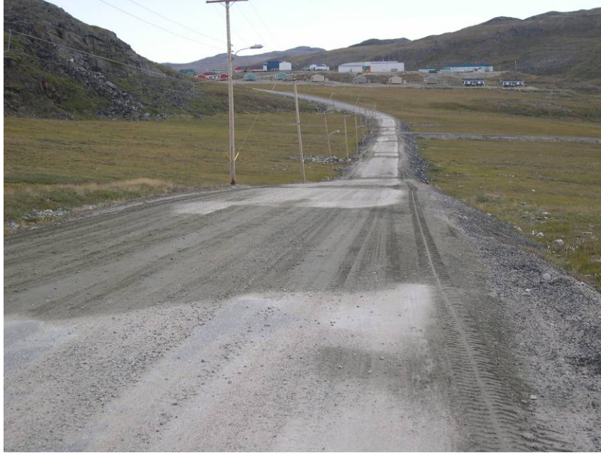
Figure 5-1 : Vue d'ensemble de la route d'accès de l'aéroport de Salluit à l'entrée du village.
