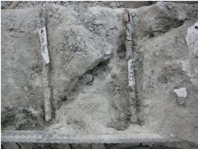
Figure 31 Essai 2Ba - Barres de renforcement #2 et #3, face sud
