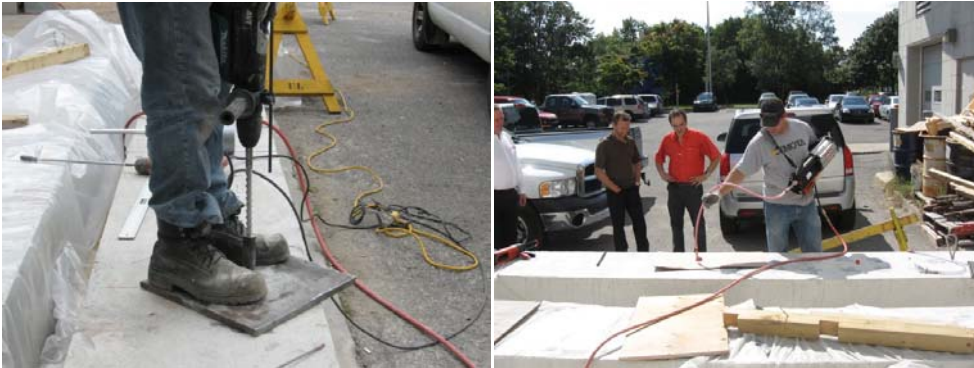
Figure 7 : Renforcement des poutres à l'Université Laval
