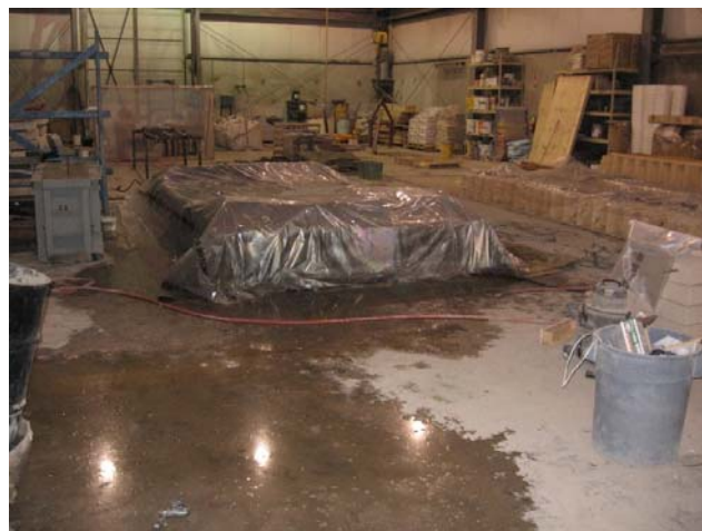
Figure 6 : Cure humide des dalles chez BPD
