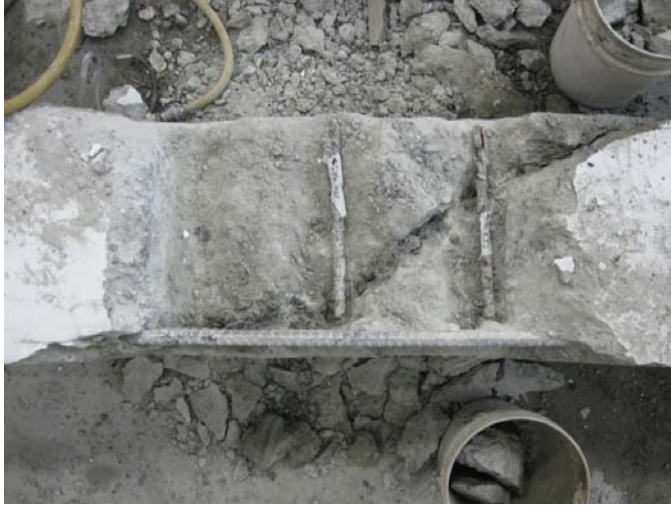
Figure 30 Essai 2Ba - Vue globale des barres de renforcement #2 et #3, face sud
