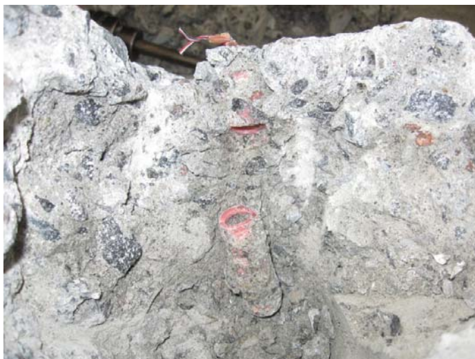
Figure 32 Essai 3Ba - Glissement d'une barre de renforcement
