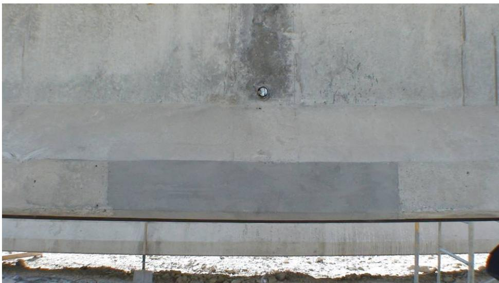
Figure B.4 : Zone endommagée après la réparation
