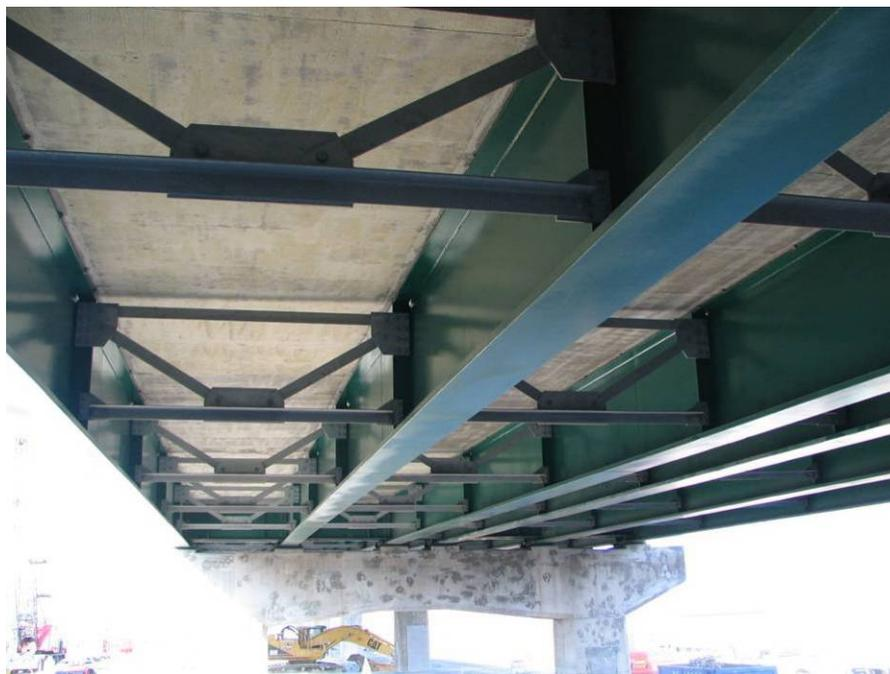
Figure 12.3 : Poutres de remplacement mixtes acier-béton des travées d'approches
