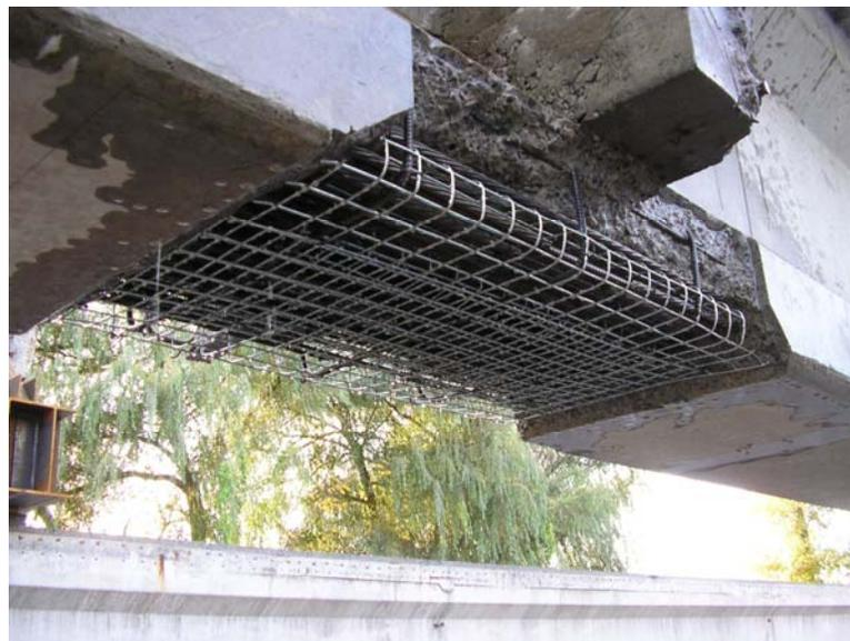
Figure 12.11 : Détails de réparation par treillis
