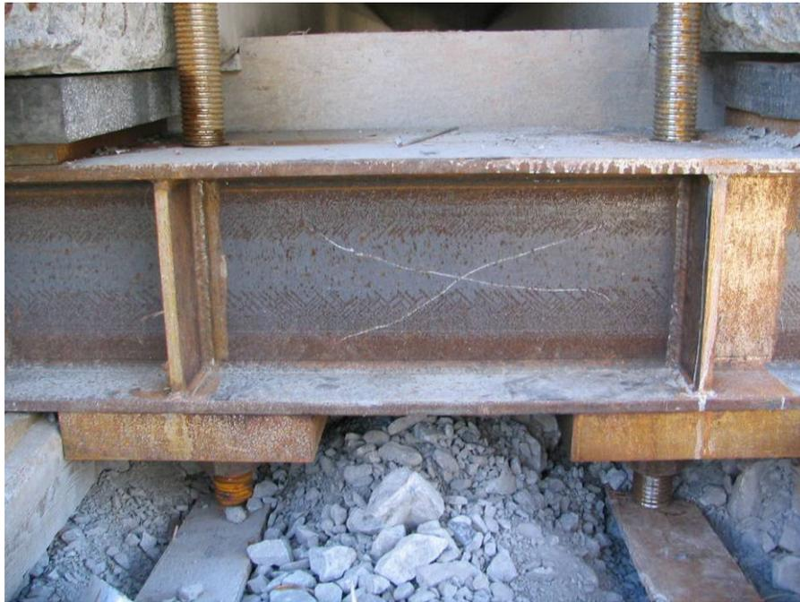
Figure 12.21 : Ancrage des tiges filetées à l'extrémité des poutres d'appui
