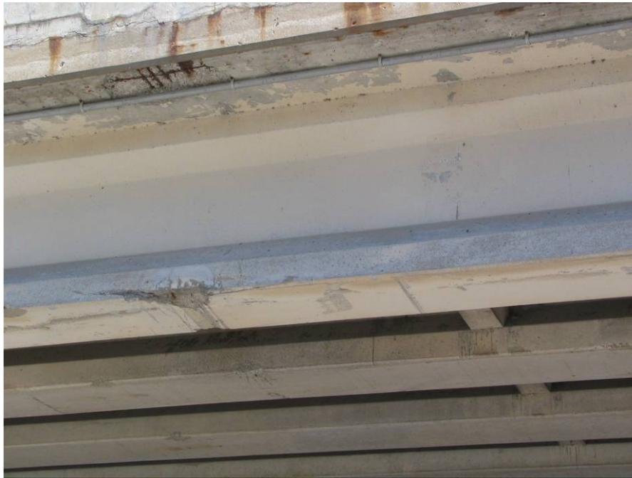
Figure 12.2 : Poutres existantes AASHTO type IV des travées d'approches
