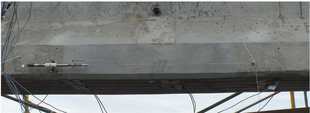
Figure 12.12 : Zone eendommagée réparée – Poutre R2
