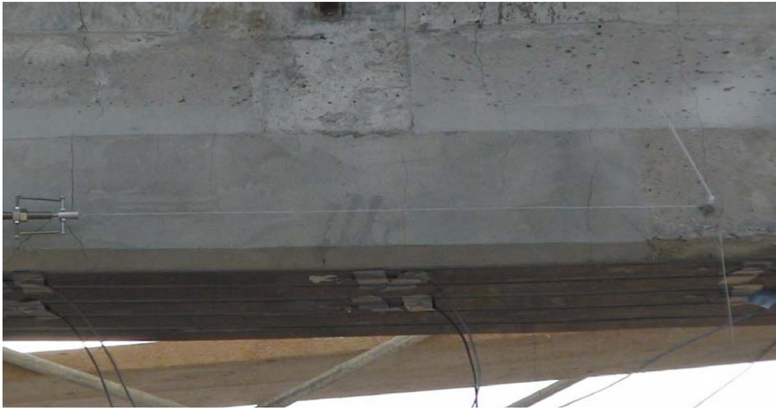
Figure 12.27 : Fissures aux extrémités et au centre de la zone réparée
