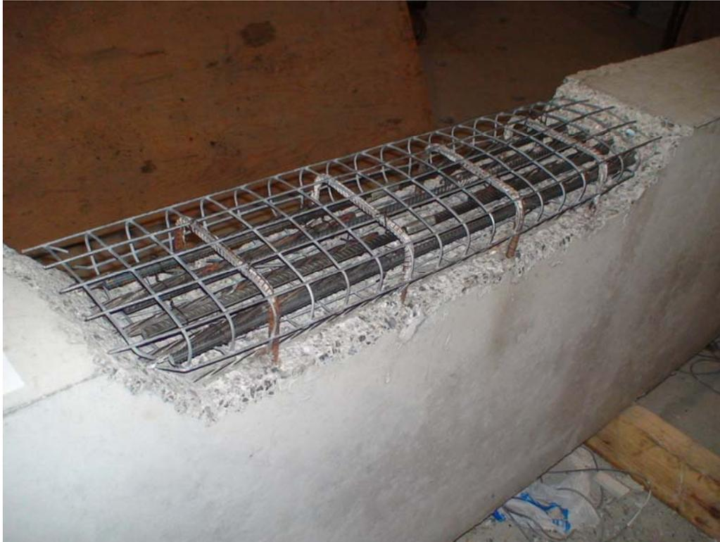
Figure 8.11 : Renforcement de la zone réparée pour la poutre L2B
