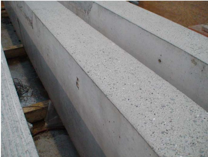
Figure 8.12 : Préparation de surface avant de collage du composite - jet de sable
