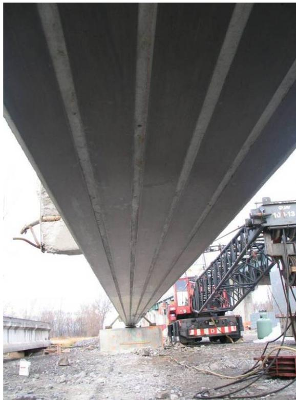
Figure 12.14 : Renforcement avec les lamelles de composite
