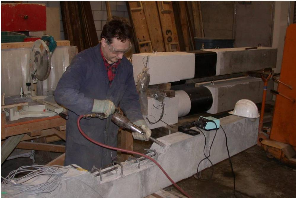
Figure 6.10 : Préparation de surface de zone endommagée
